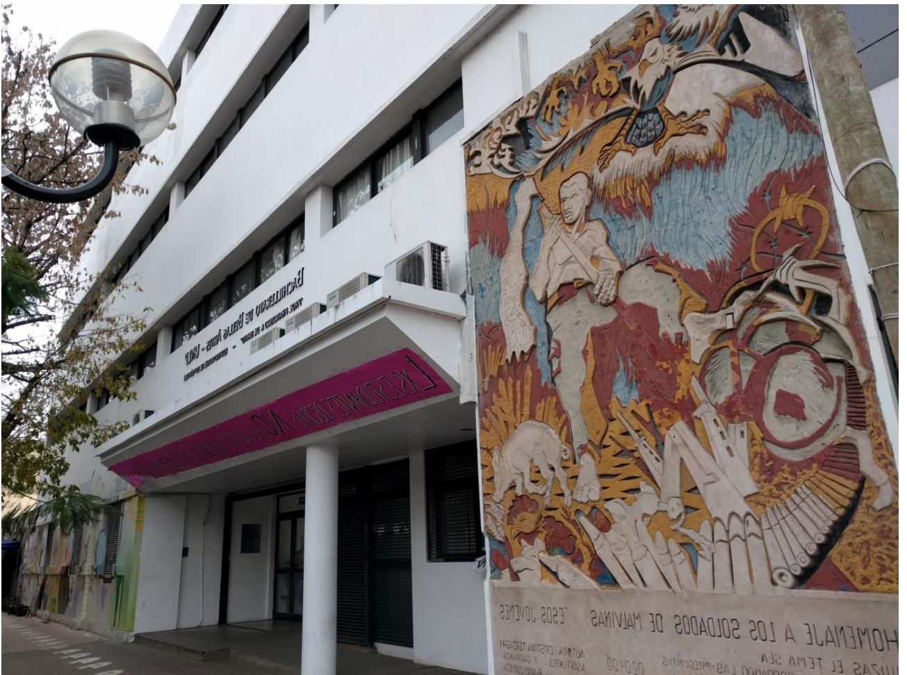
FRENTE DIAGONAL 78 Y CALLE 10 y ACCESO SOBRE CALLE 10
