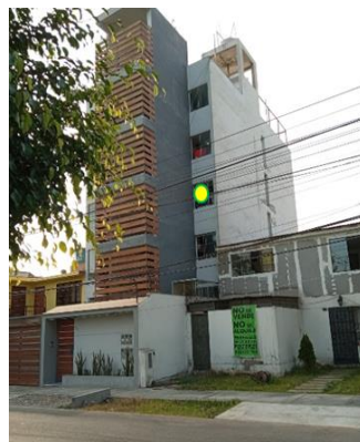
Figura 37. Foto 03. Elevación Lateral derecha
