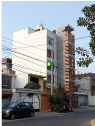
Figura 36. Foto 02. Elevación Lateral izquierda
