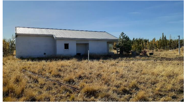
Fig.12 – Fotografía en posición 4. Vista de la fachada sur.
