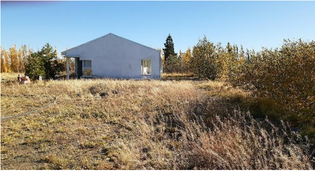
Fig. 11 – Fotografía en posición 3. Fachada este. A la se puede apreciar la zona de acceso a la vivienda.
