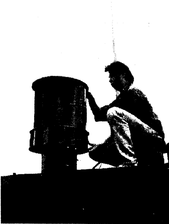
Fig.8 Prototipo ensayado en torre de servicios, Facultad de Arquitectura y Urbanismo, UNT.
