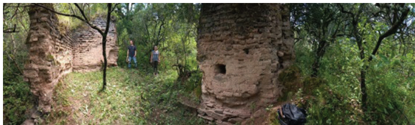
Figura 10. Galpón que alojaba la maquinaria hidráulica del molino
