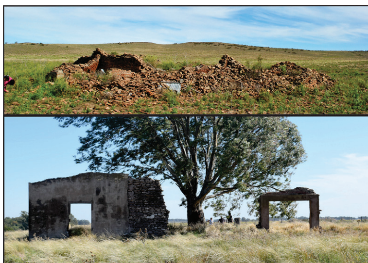
Figura 2. Estado actual de las construcciones; arriba: pulpería PM; abajo: boliche LS
