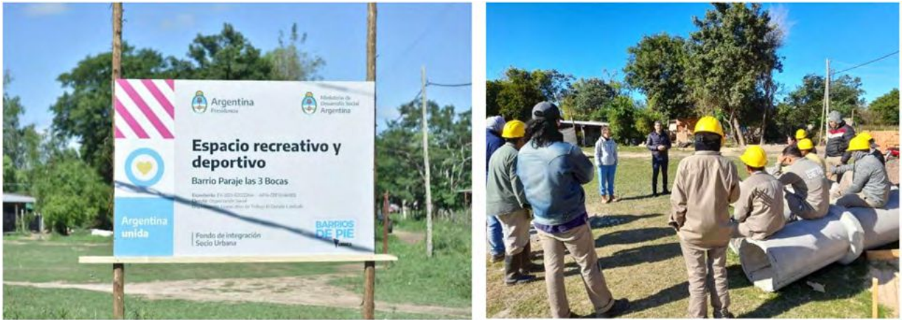
Cartel de obra y cooperativa de trabajo, junto a representantes territoriales y técnicos, para la construcción del Espacio recreativo y deportivo del paraje Las Tres Bocas de la Organización Barrios de Pie. Abril de 2022. Fuente: Área de comunicación de la Organización Barrios de Pie. Ph: Pablo Rivero
