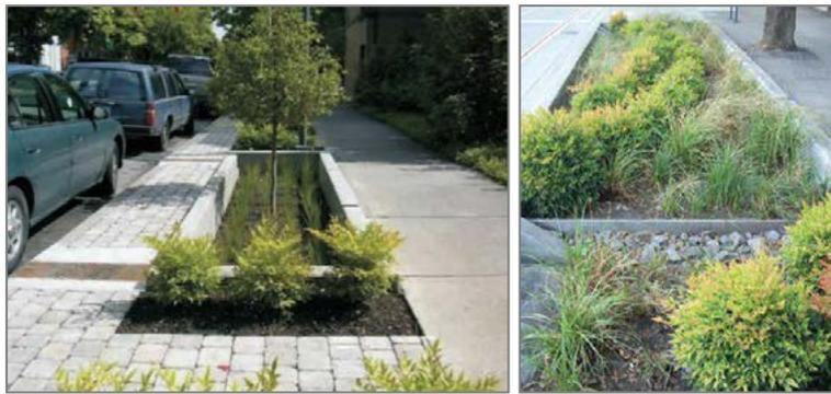
Figura 2.- Celdas de biorretención
