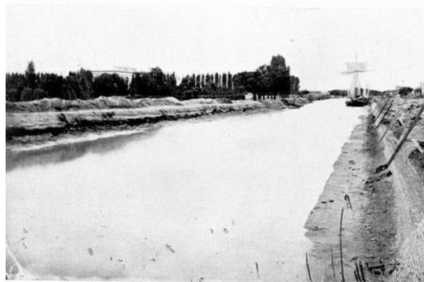
Fig.2 Murallón de ladrillo sobre la ribera Este del Canal de San Fernando (foto s/f en Histamar web)
