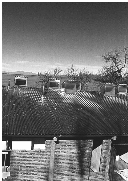
c. Vista norte de una porción de fachada, vista de lucernarios
