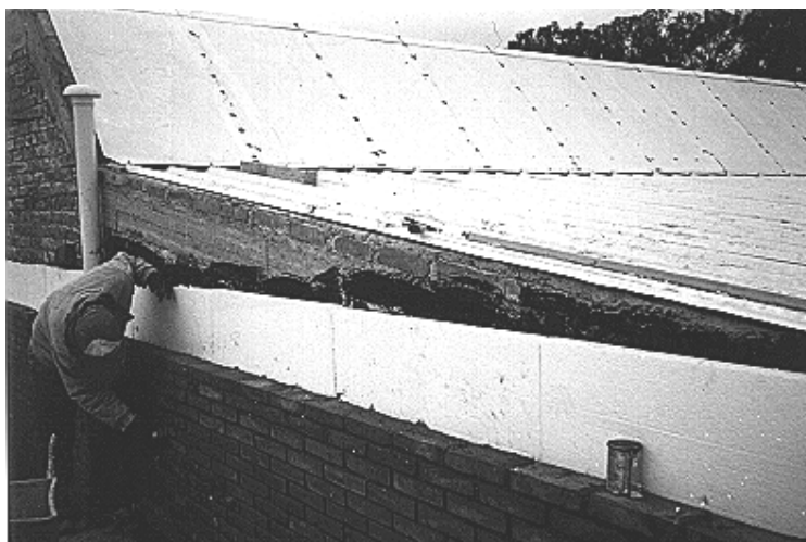
Figura N°3b. Detalle de Colocación de Aislación Térmica y Muro de Revestimiento
