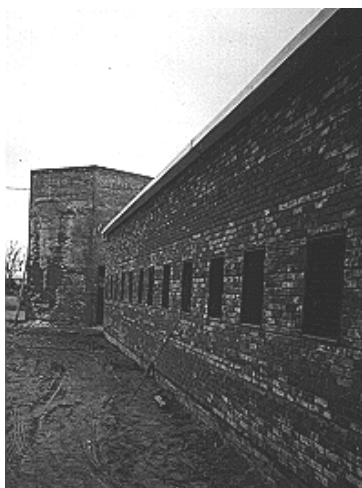
Figura N°3a. Vista Sur del Bloque de aulas
