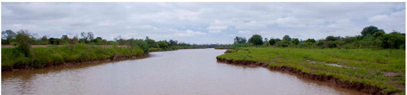
Canalización del río Pilcomayo con barrera de contención a la izquierda.
