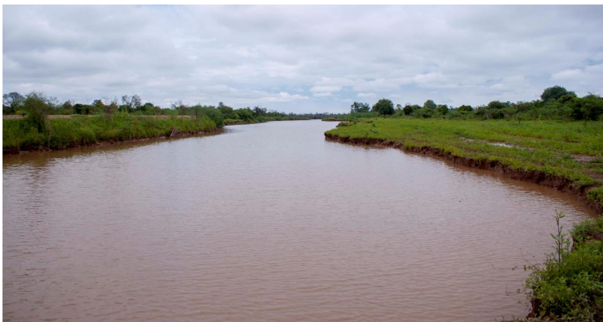
Figura 4.3 Canalización del Bañado La Estrella en la comunidad Sombrero Negro con barrera de contención a la izquierda. Foto tomada por el autor.
