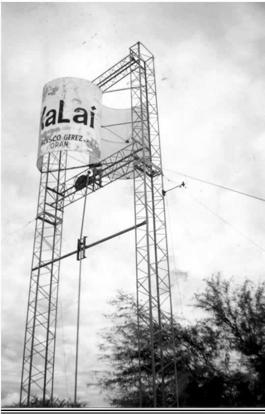
Fig1 Turbina Savonius
