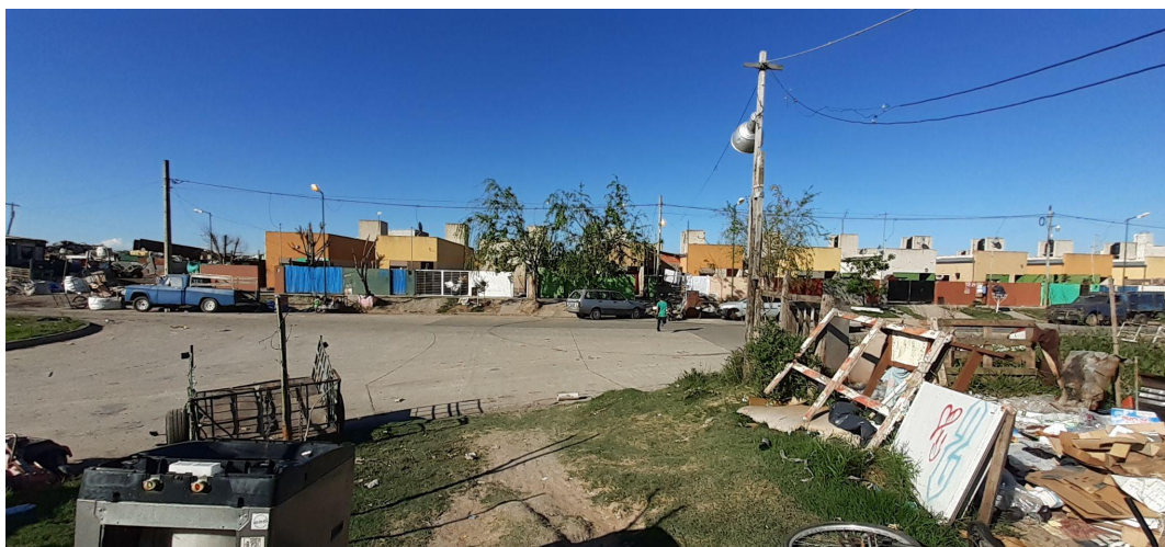
Figura 48: Viviendas, basurales y tendidos eléctricos contruidos por los vecinos en el barrio “Nuevo” en Octubre de 2021. Fuente: Trabajo de campo.
