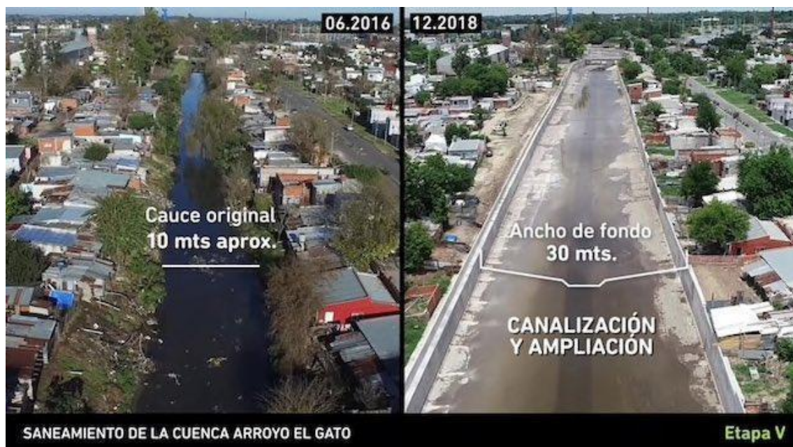
Figura 27: Antes y después en el sector del Arroyo del Gato Correspondiente a la etapa V de la obra hidráulica llevada adelante por el Ministerio de Infraestructura de la Provincia de Buenos Aires. Disponible en https://www.youtube.com/watch?v=hl1LYz5MdCE&ab_channel=RevistaLaTecla
