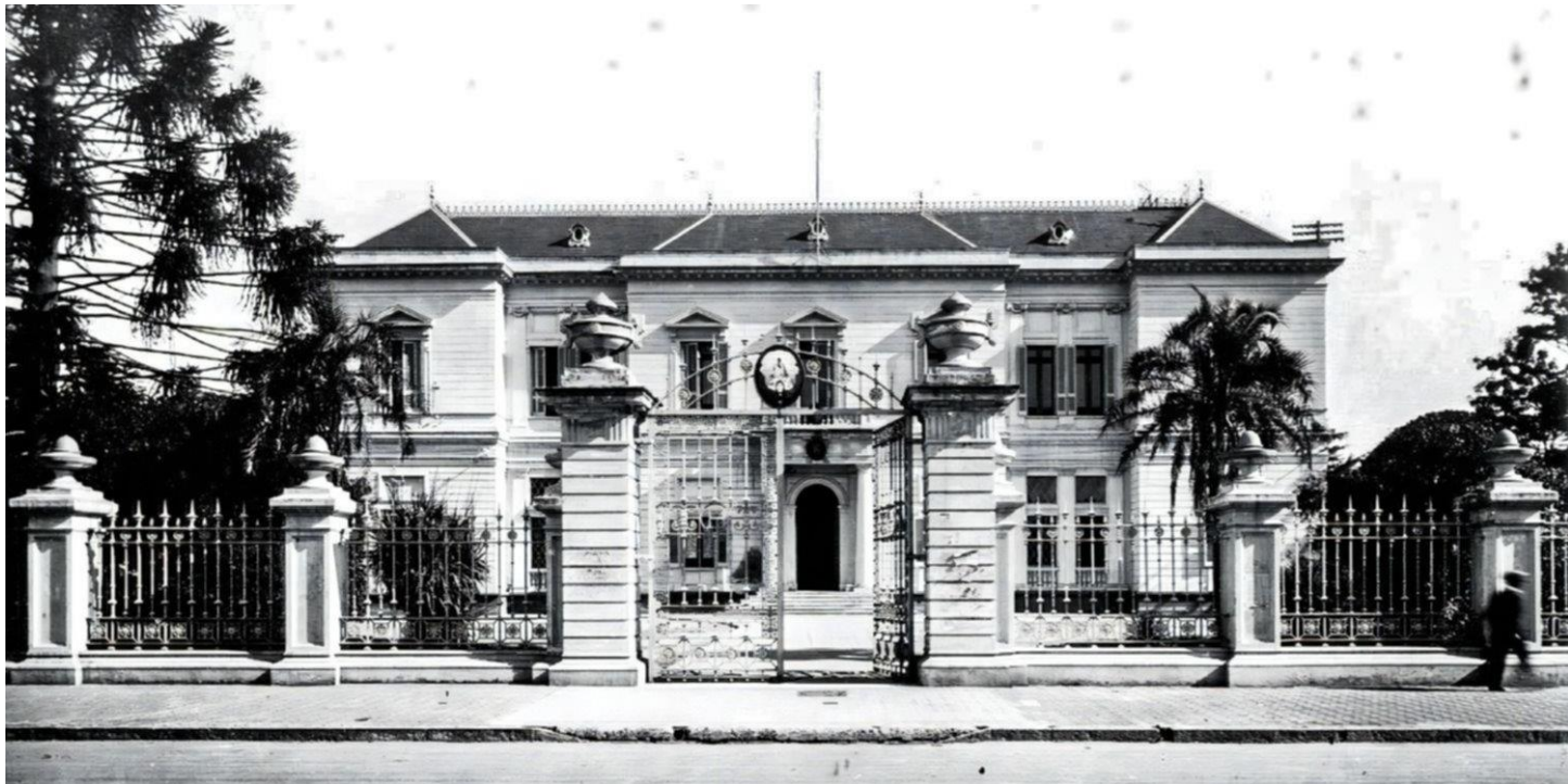
FACHADA CALLE 6 DEL BANCO HIPOTECARIO DE LA PROVINCIA DE BUENOS AIRES - ACTUAL RECTORADO
