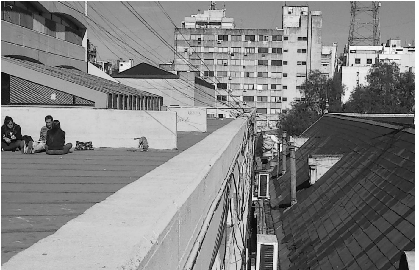
MANZANA DEL RECTORADO. RELACIÓN EDIFICIO HISTÓRICO CON EDIFICIO "TRES FACULTADES", HOY EDIFICIO "SERGIO KARAKACHOFF" (PREVIO A SU INTERVENCIÓN)
