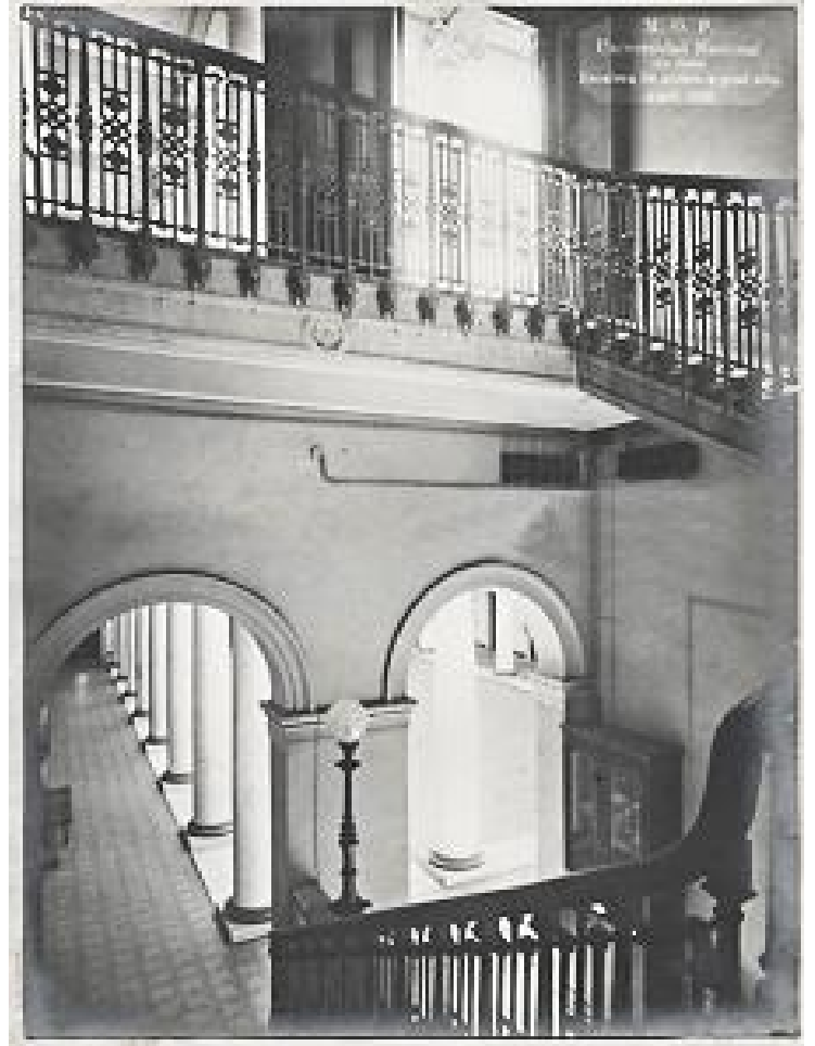
ESCALERA PRINCIPAL Y GALERÍAS DEL PATIO INTERIOR.
