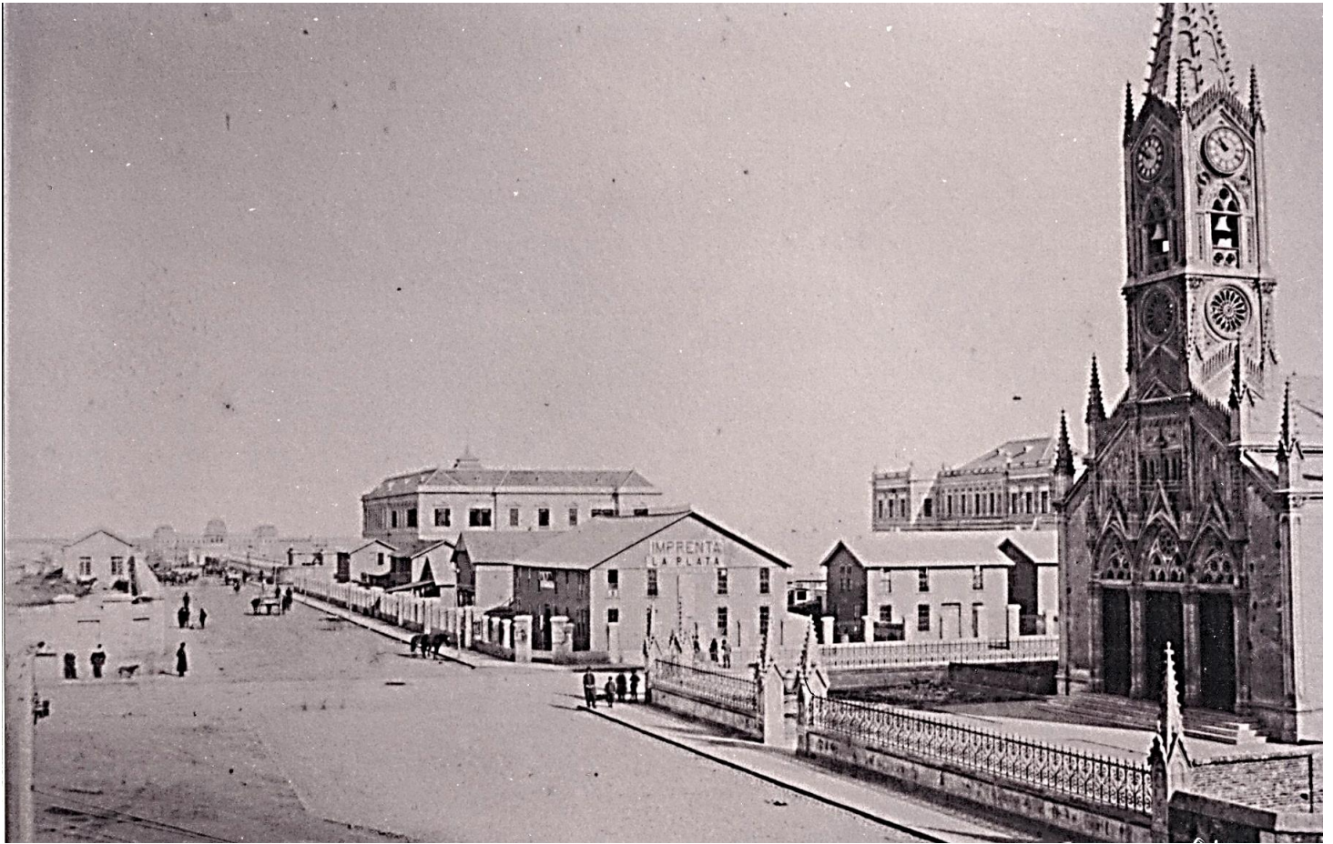
VISTA DESDE CALLE 48 Y DIAGONAL 80 HACIA AVENIDA 7 DE IZQUIERDA A DERECHA: EDIFICIO RECTORADO UNLP, ANTIGUA IMPRESA LA PLATA, BASÍLICA DE SAN PONCIANO
