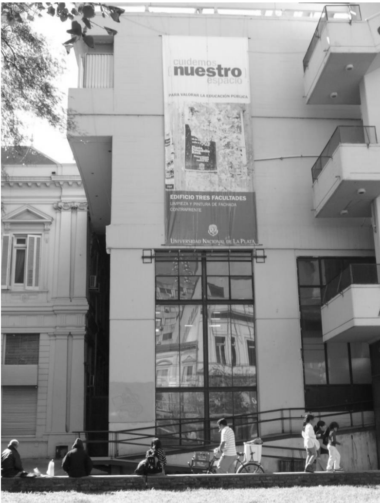
MANZANA DEL RECTORADO. RELACIÓN EDIFICIO HISTÓRICO CON EDIFICIO "TRES FACULTADES", HOY EDIFICIO "SERGIO KARAKACHOFF" (PREVIO A SU INTERVENCIÓN) VISTA DESDE AVENIDA 7
