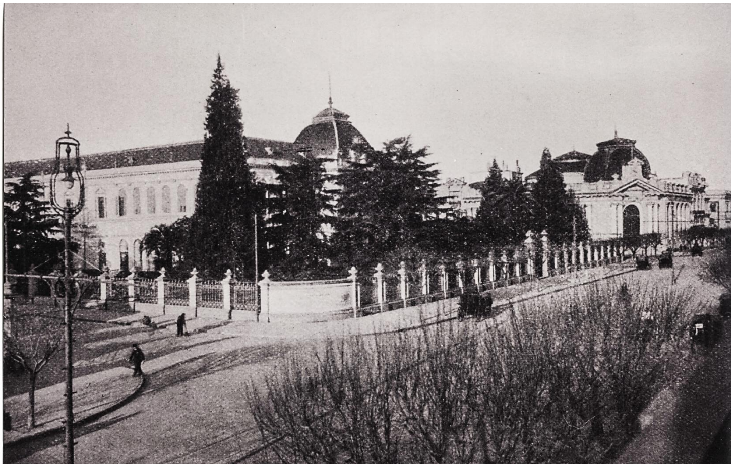
FACHADA AVENIDA 7 Y CALLE 47 DEL BANCO HIPOTECARIO DE LA PROVINCIA DE BUENOS AIRES - ACTUAL RECTORADO
