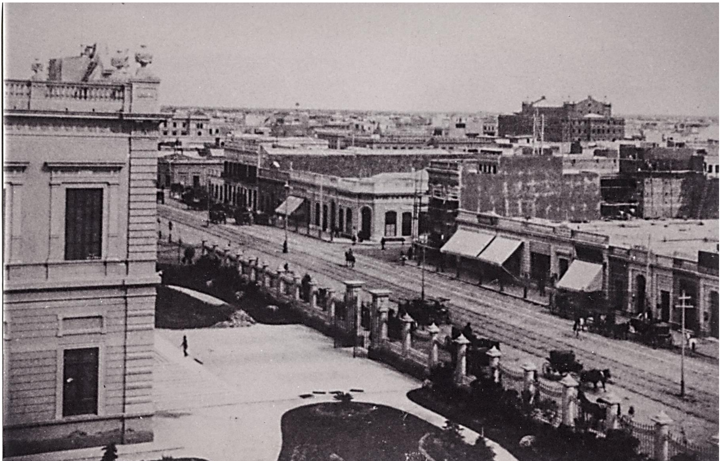
VISTA DESDE CALLE 47 HACIA AVENIDA 7 DEL BANCO HIPOTECARIO DE LA PROVINCIA DE BUENOS AIRES - ACTUAL RECTORADO
