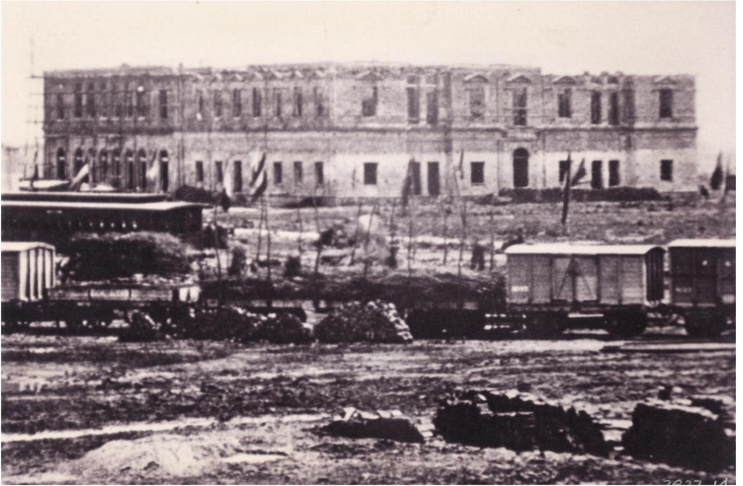
CONSTRUCCIÓN DEL BANCO HIPOTECARIO DE LA PROVINCIA DE BUENOS AIRES - ACTUAL RECTORADO
