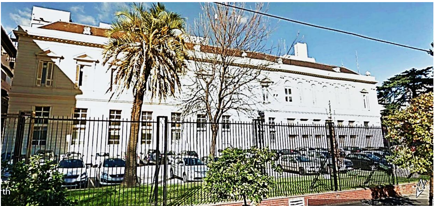
EDIFICIO DEL RECTORADO FACHADA HACIA CALLE 47 - CONDICIÓN ACTUAL
