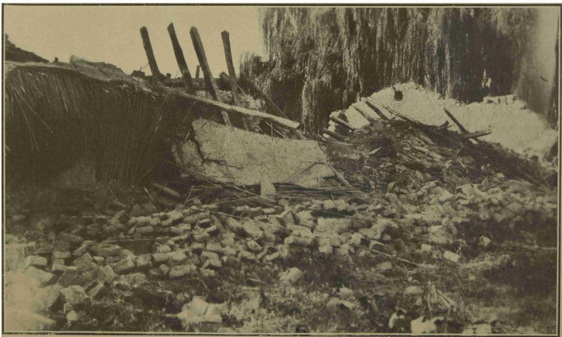
6. Panquegua Interior de la Escuela Provincial
