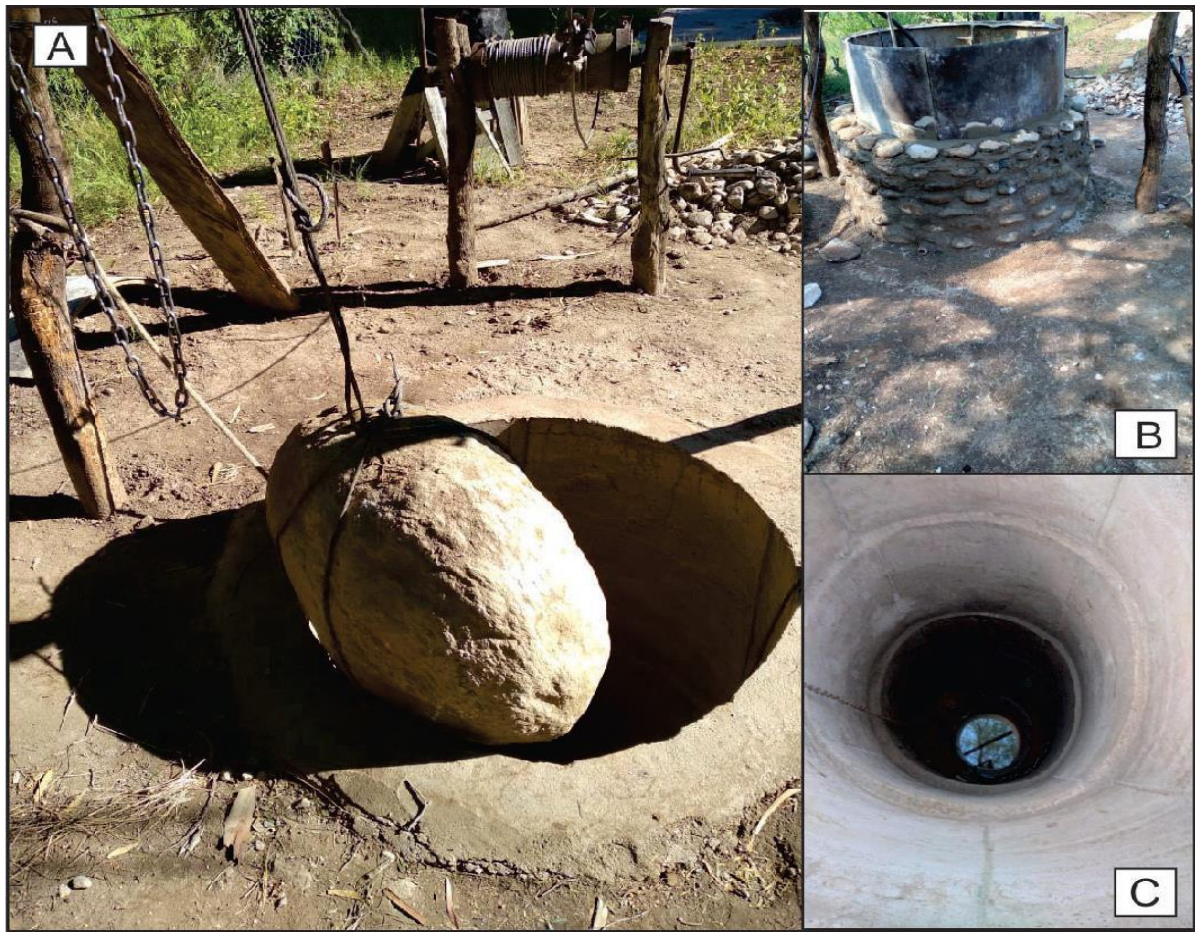
Figura 8: a) Se puede observar el pozo P-6, el cual fue abandonado debido a que no se logró dar con el acuífero. El pozo llegó a una profundidad de excavación de 60 metros sobre conglomerados grueso con bloques de hasta 1 m de diámetro. b) Imagen correspondiente al pozo P-3 con nivel freático a 4 metros. c) Se puede observar el nivel freático del pozo P-2 a una profundidad de 5 metros.
