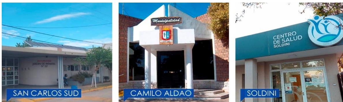
Figura 3: Edificios municipales seleccionados
