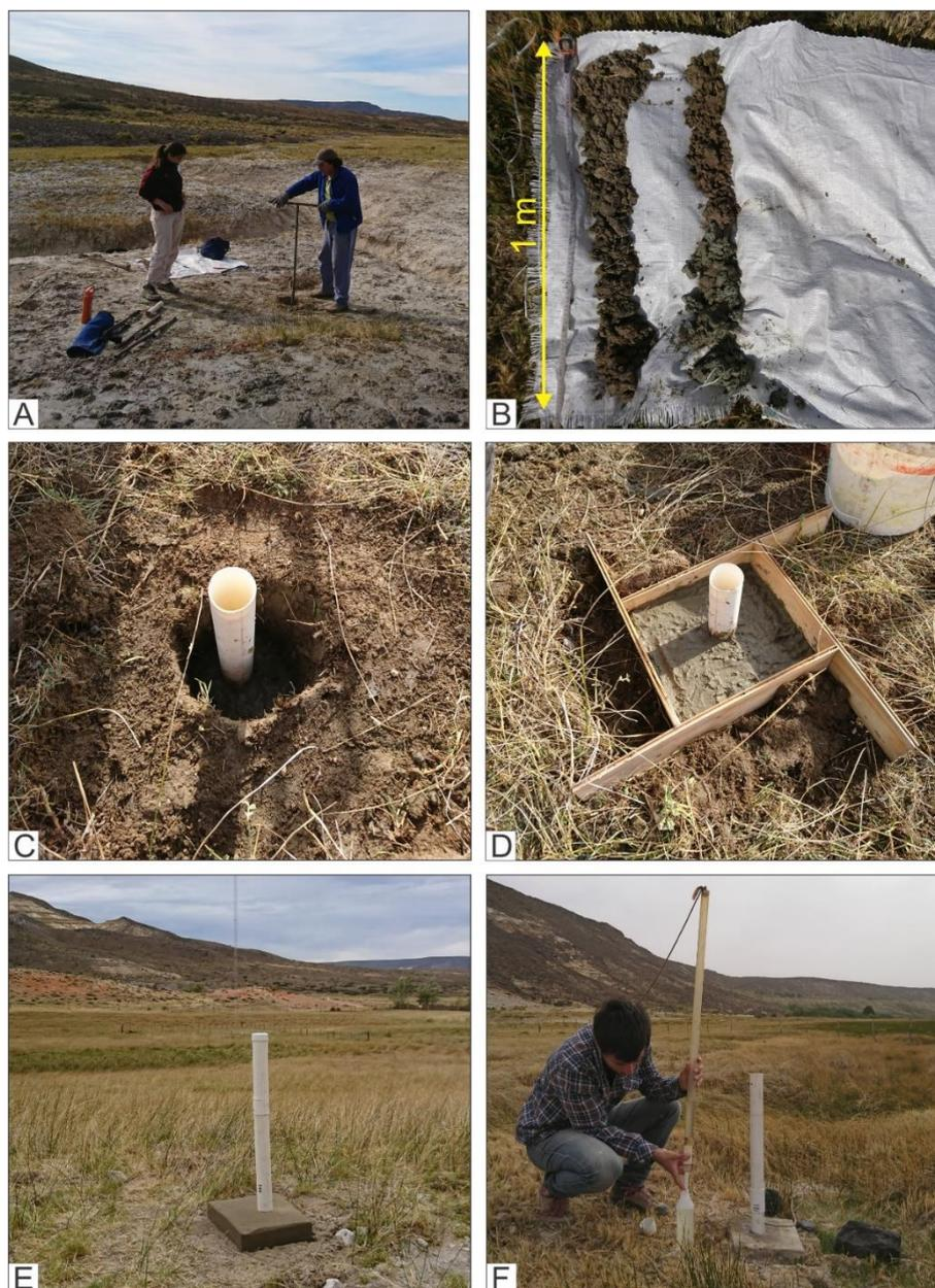
**Figura 2.5.** Fotografías que muestran la realización de los freáticos: a. Perforación con barreno manual; b. Perfil obtenido por metro de avance durante la perforación. c. d. y e. Terminación de freático; f. Muestreo de agua subterránea con bailer.
