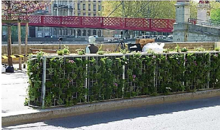
Figura 91 Barreras bajas divisorias entre carriles de tránsito
