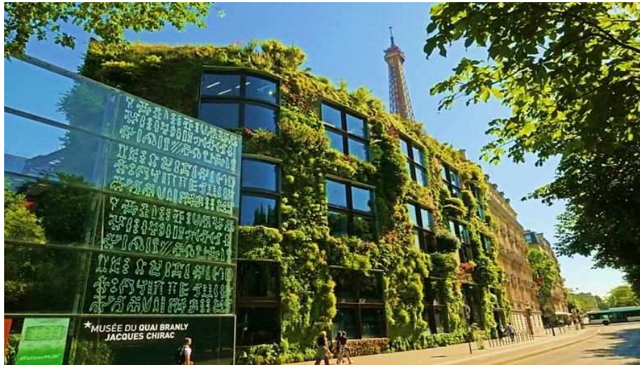
Figura 26 Jardín vertical de filtros en la fachada del Museo de Quai Branly Jacques Chirac (Botánico Patrick Blanc, Paris, 2004)
