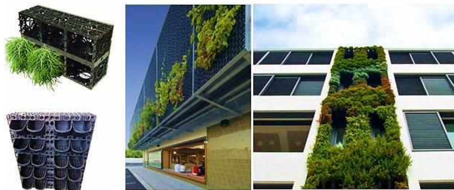
Figura 81 Ejemplo de un sistema modular: Sistema GroWall
