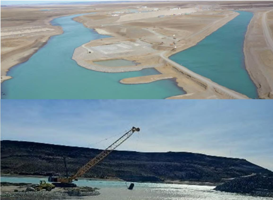
*Figura 14.- Trabajos de preparación del cauce para asegurar el desvío del río. Presa JC. Noviembre
