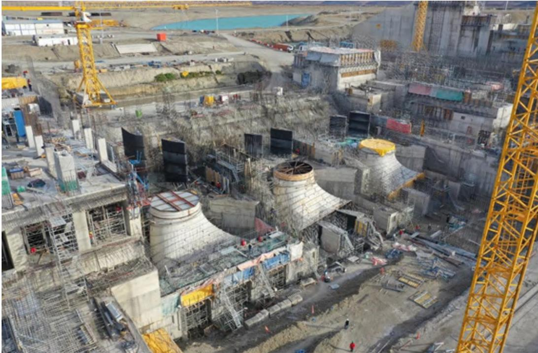
*Figura 12.- Vista de los tubos de aspiración de las tres turbinas del aprovechamiento JC*
