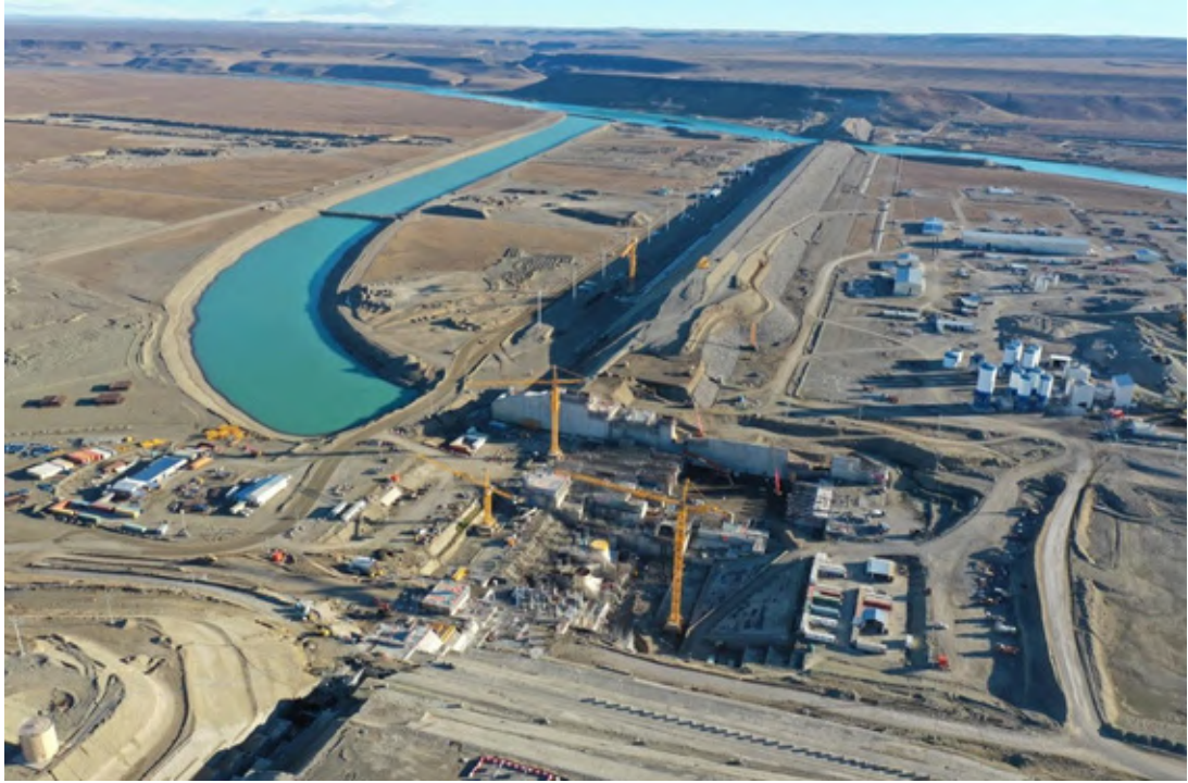
Figura 10.- Estado de avance de la obra JC. Mayo 2023
