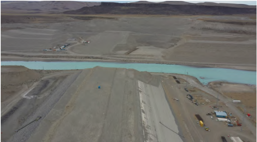
Figura 11.- Estado de avance de la obra NK. Noviembre 2022
