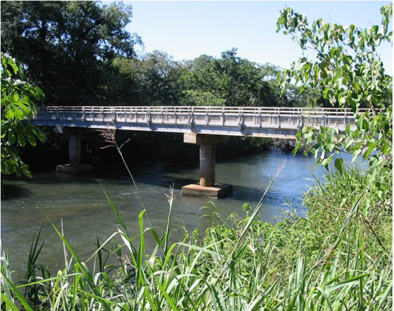
Vista lateral de tableros y una pila con su viga dintel y su cabezal de pilotes
