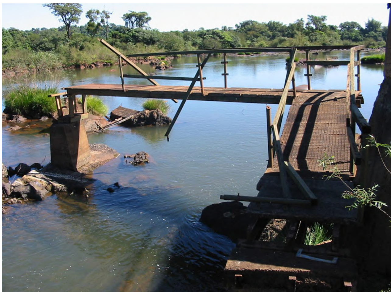
Tramo de acceso a pasarela histórica en Garganta del Diablo
