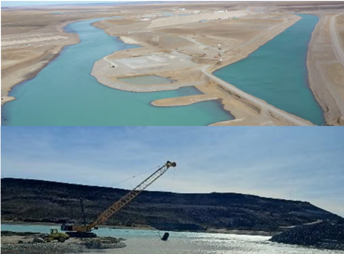
Figura 14.- Trabajos de preparación del cauce para asegurar el desvío del río. Presa JC. Noviembre 2022 (izquierda); Septiembre 2023 (derecha)
