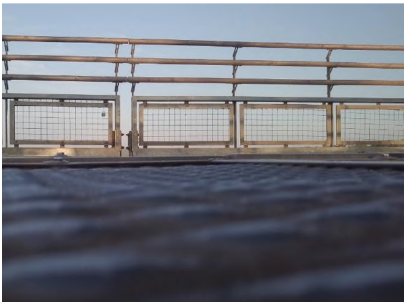
Tramos laterales con pasamanos a altura standard, para niños, y para sillas de ruedas, más guarda-pie y malla artística de protección
