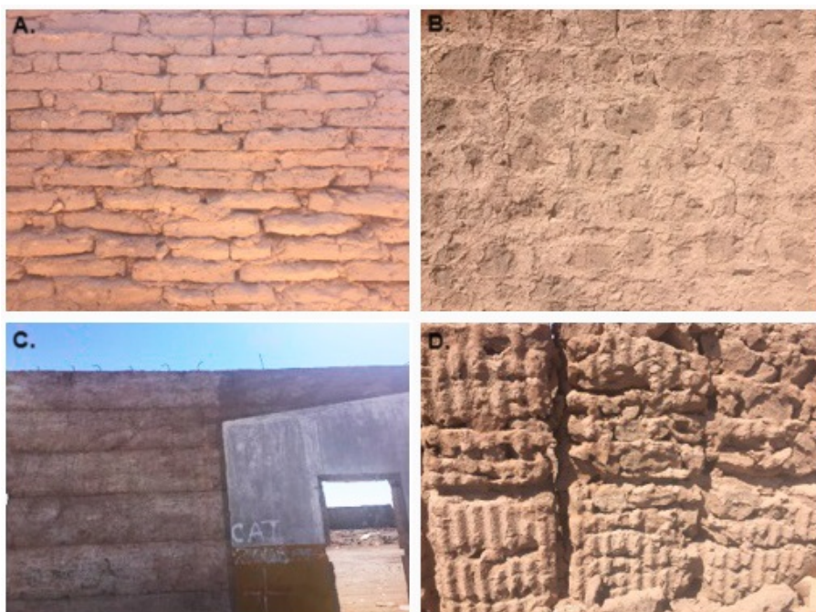
Figura 2: Técnicas constructivas en Pampa Unión. (A) Adobe. (B) Mampostería en costra calichal. (C) Hormigón armado (D) Tapial.
