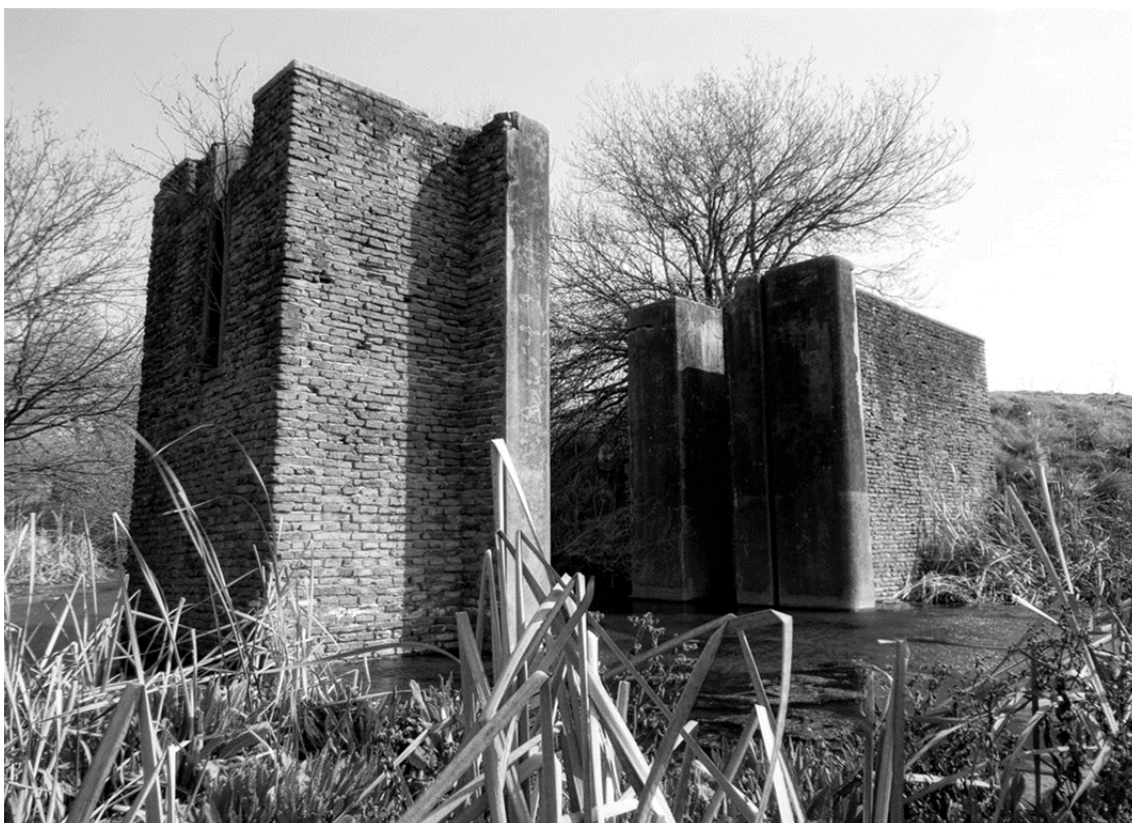
Fotografía N°3. Restos de esclusas para compuertas. Fuente:
