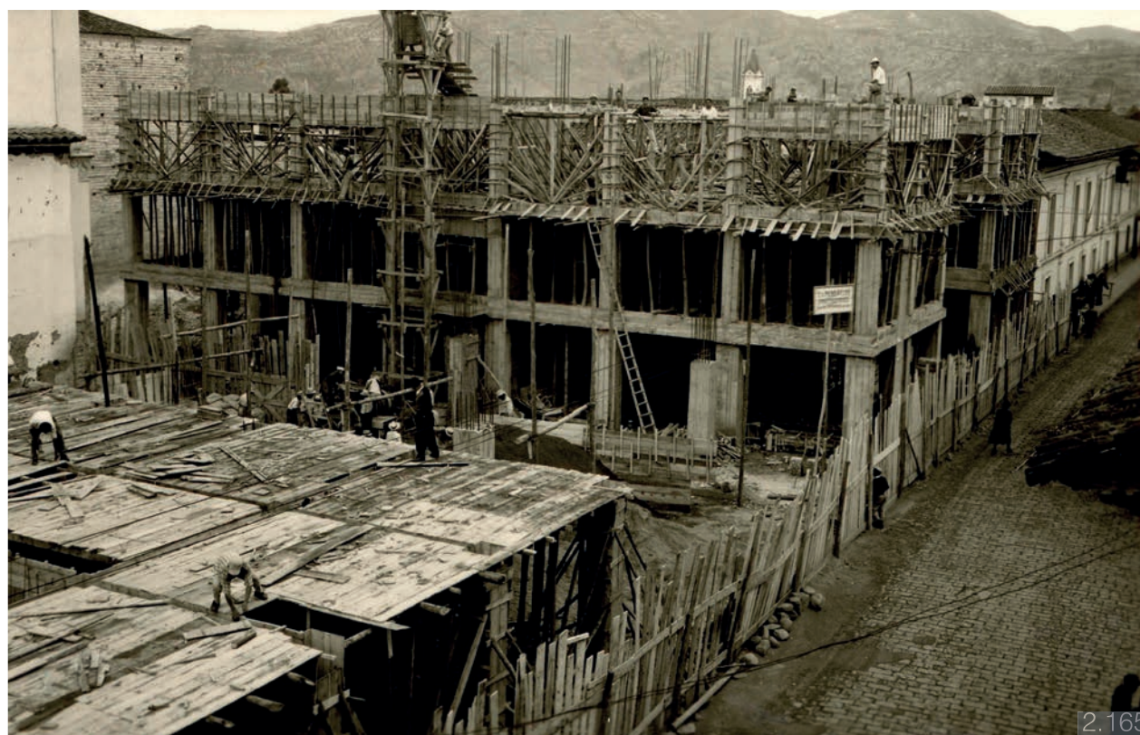
Figura 2.164: Armado estructural de la Casa de la Cultura
