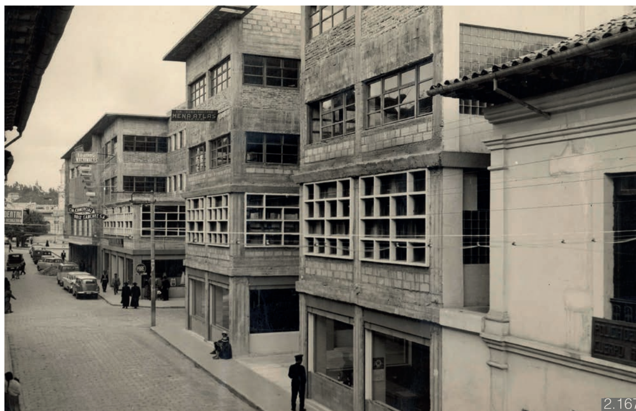
Figura 2.166: Fachada en obra gris Fuente: Biblioteca privada del Sr. Miguel Díaz Cueva (1957)
