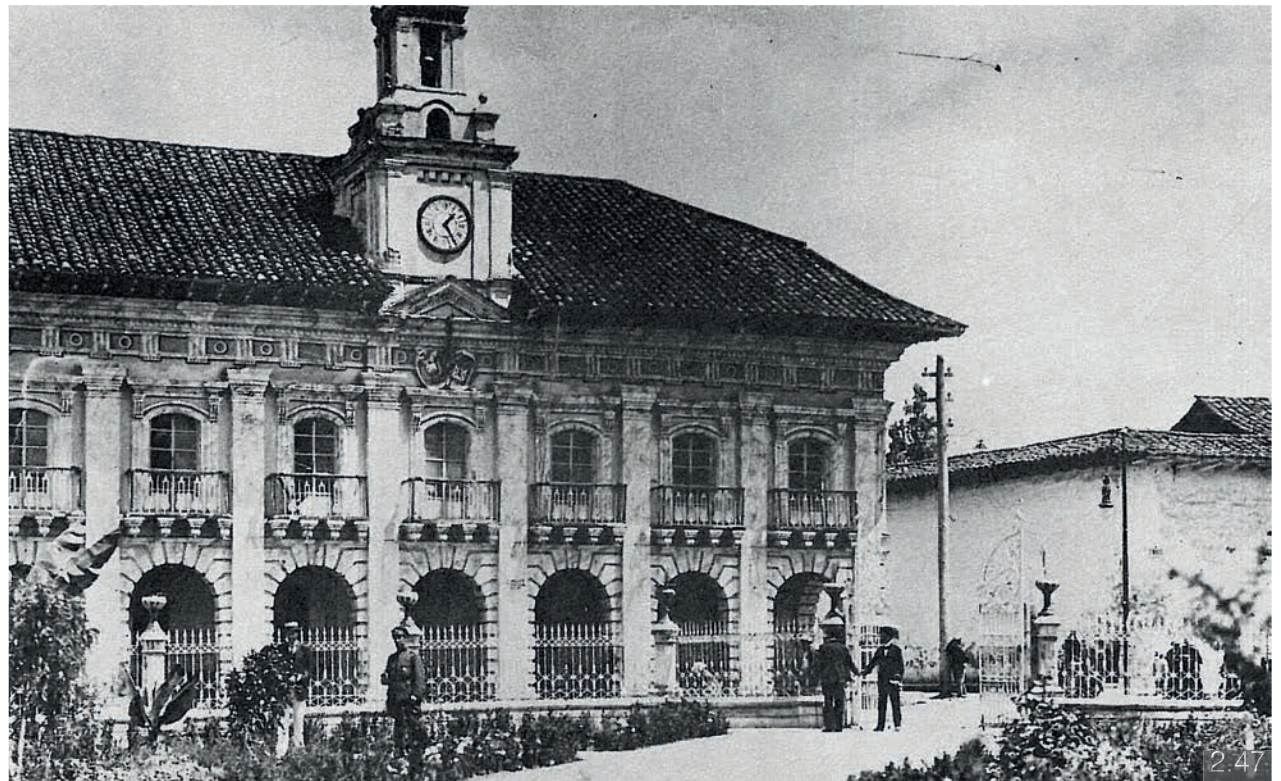
Figura 2.47: Antiguo Palacio Municipal, al frente se observa el muro del claustro de la orden del Carmen
