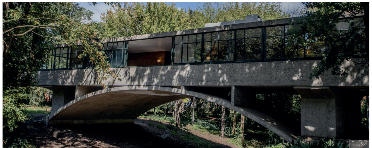
Figura 1.32: Fotografía actual al exterior de la vivienda atravesada por el Arroyo.
