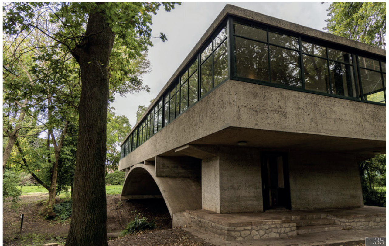
Figura 1.35: Estado actual del exterior de la vivienda después de su intervención.
