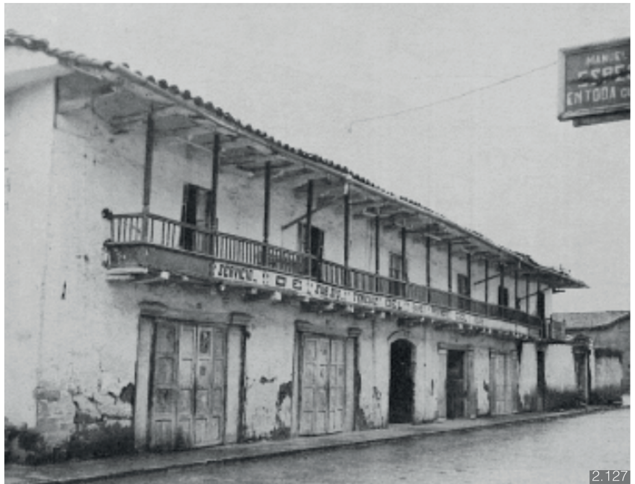
Figura 2.127: Antigua casa ubicada en el terreno de la Casa de la Cultura donde actualmente funciona el teatro.
