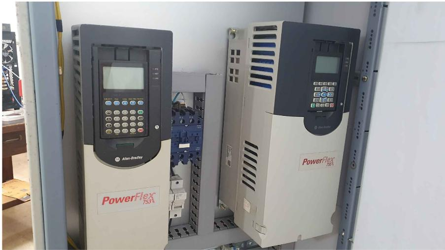
Figura 10: Variadores de velocidad utilizados en el banco de emulación.
