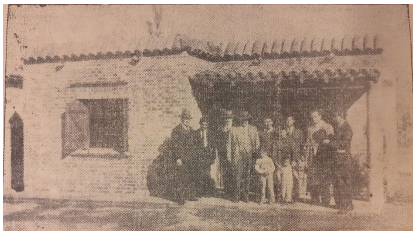
Figura 12: Casita del Ministerio de reconstrucción.
