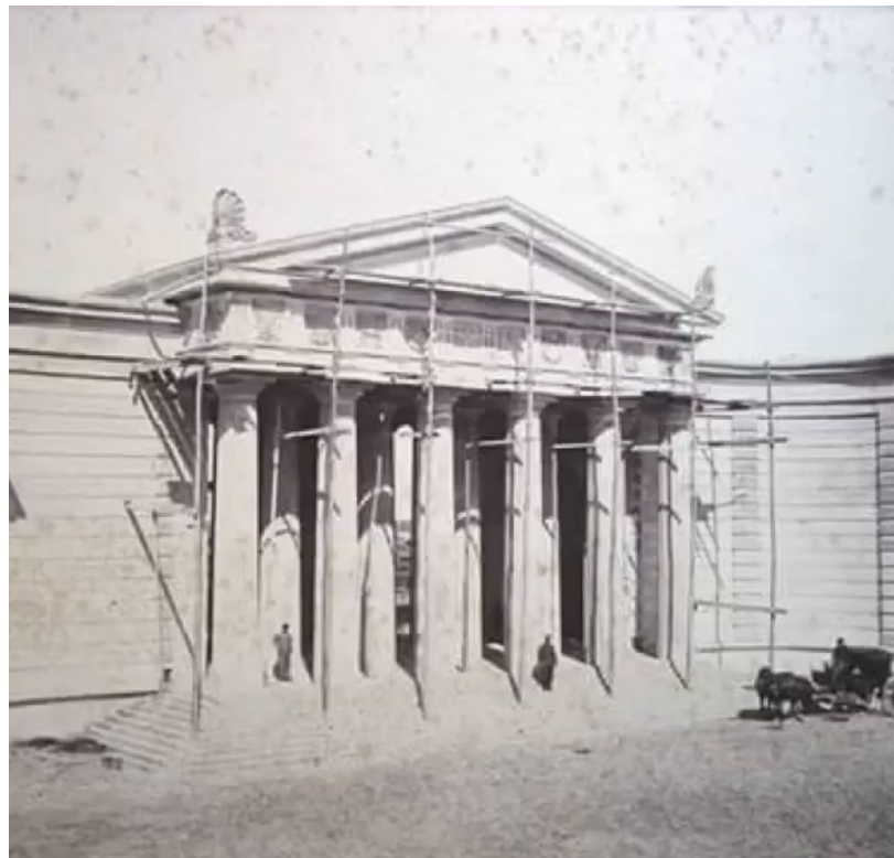
[Fig.7b] Cementerio en construcción
