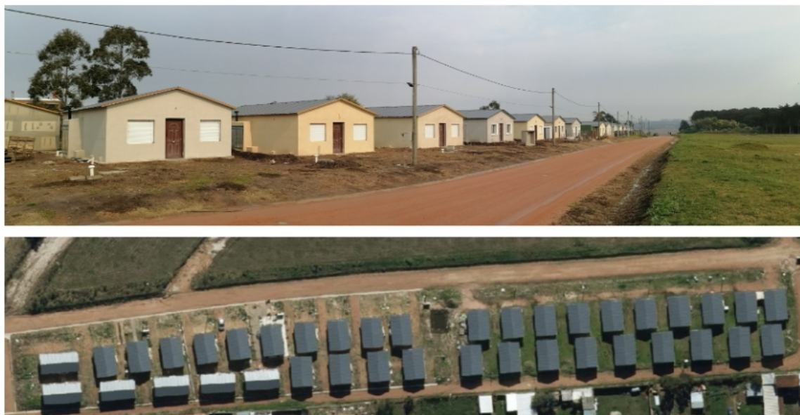
Figura 44 Barrio La Fortuna: conjunto de viviendas en el límite de los barrios La Fortuna y Lausana señalado como disruptivo por varios entrevistados (año 2020).
