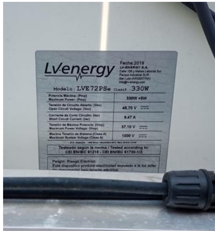
Imagen 28: Especificaciones técnicas en el reverso de los módulos, planta fotovoltaica O'Higgins
