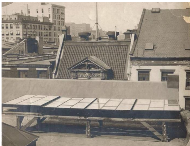
Imagen 1: Prototipos de paneles fotovoltaicos desarrollados por Frits, sobre un techo neoyorquino. Fuente: Chu y Tarazano, 2019.
