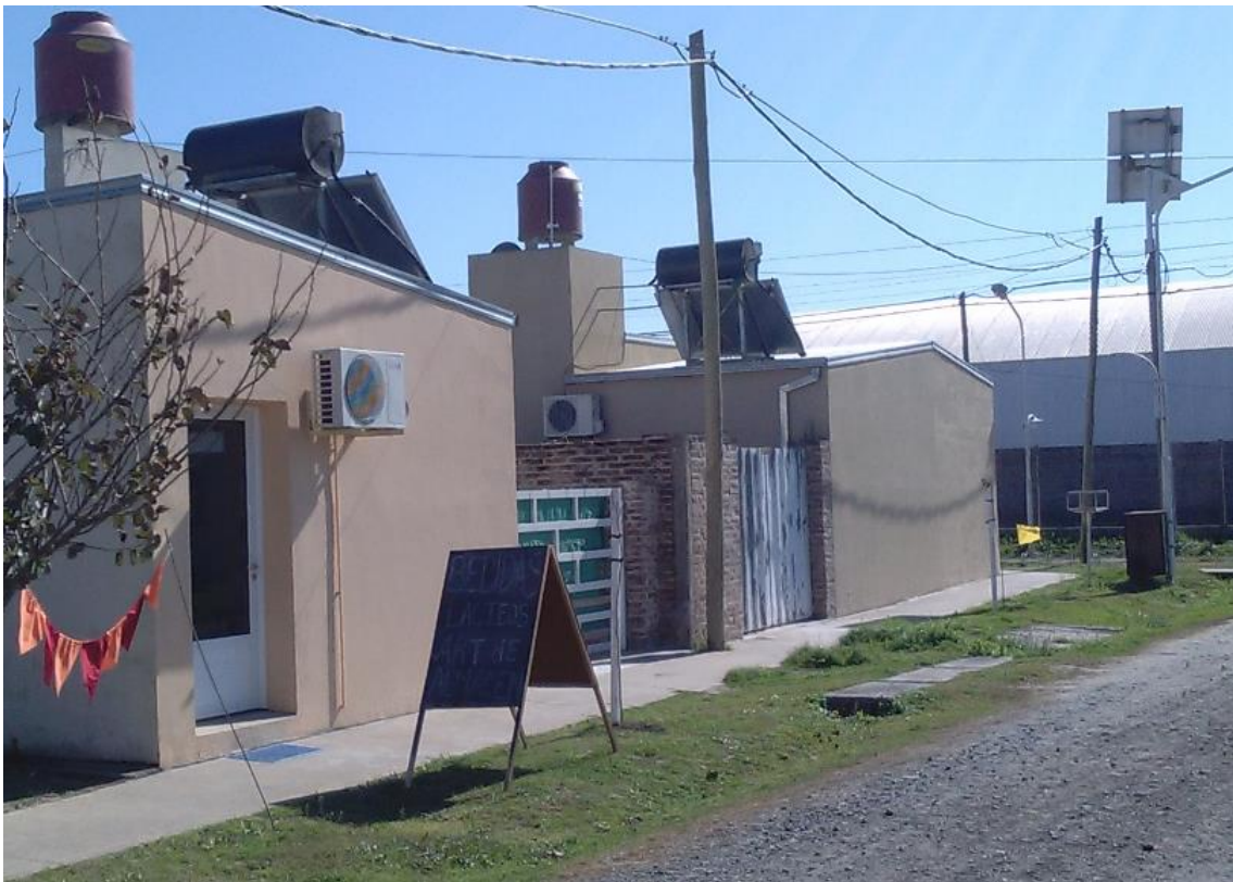
Imagen 15: Barrio solar San Carlos Sud
