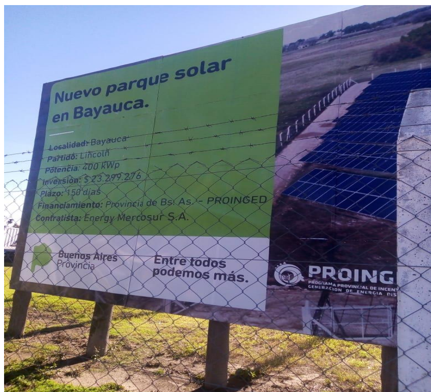
Imagen 8: cartelería tras alambrado perimetral que rodea al parque solar Bayauca, sobre última calle del pueblo.
