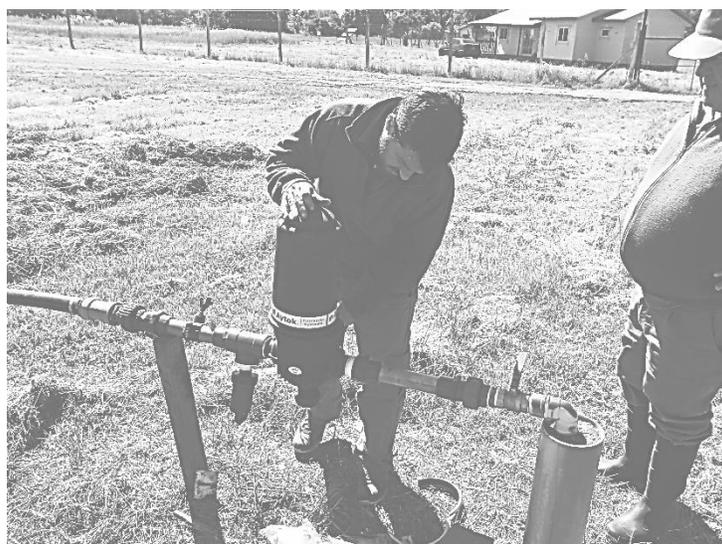
**Figura 3.3.** Momento de armado del cabezal, colocando uno de los dos filtros de anillas.
