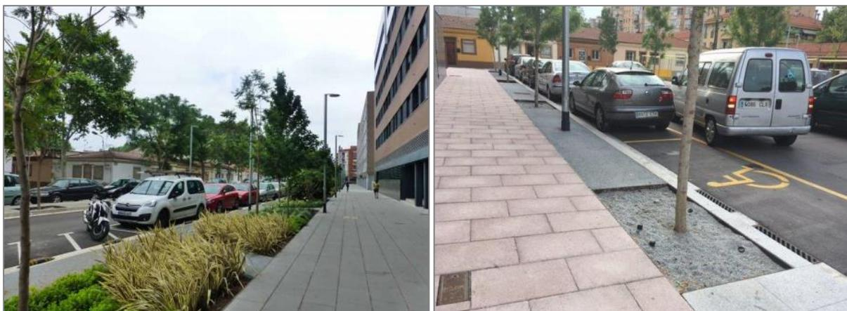
Figura 7.- Barrio Bon Pastor en Barcelona. Izq.: áreas de biorretención en veredas. Der.: Pavimento permeable y alcorques de infiltración. Fuente: Soto-Fernández, R., Perales-Momparler, S. (Ref. 11).
