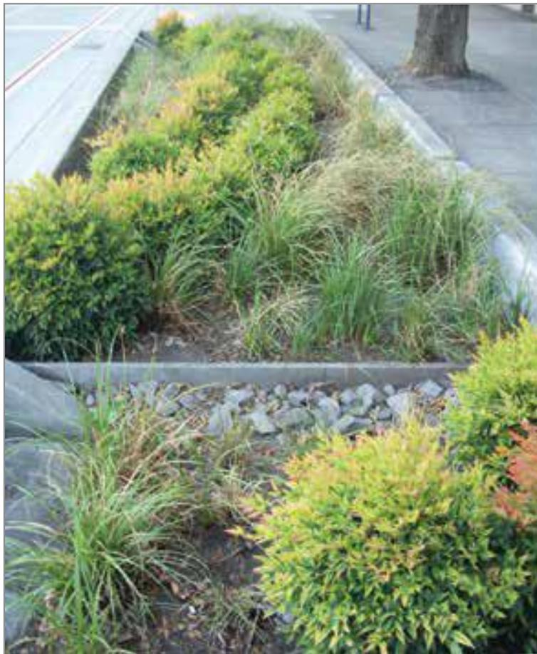
Figura 33.- Celda de biorretención (Ref. 3)
