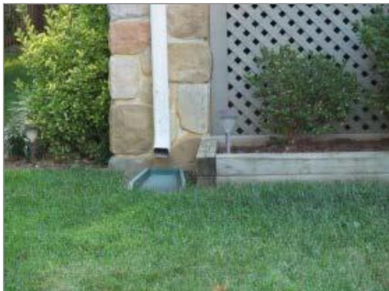
Figura 30.- Desconexión de techo (Ref. 21)
