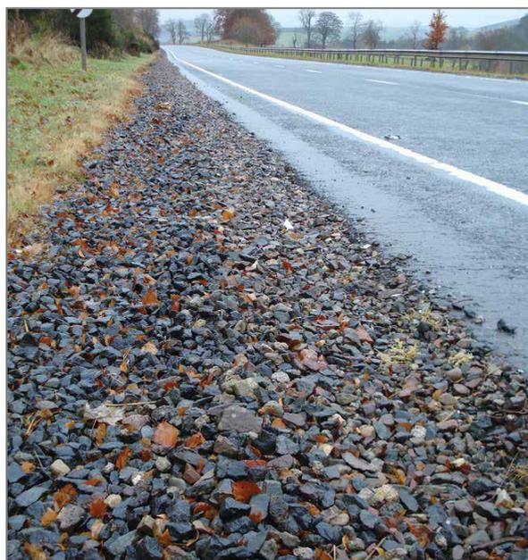
Figura 28.- Zanja de infiltración (Ref. 3)
