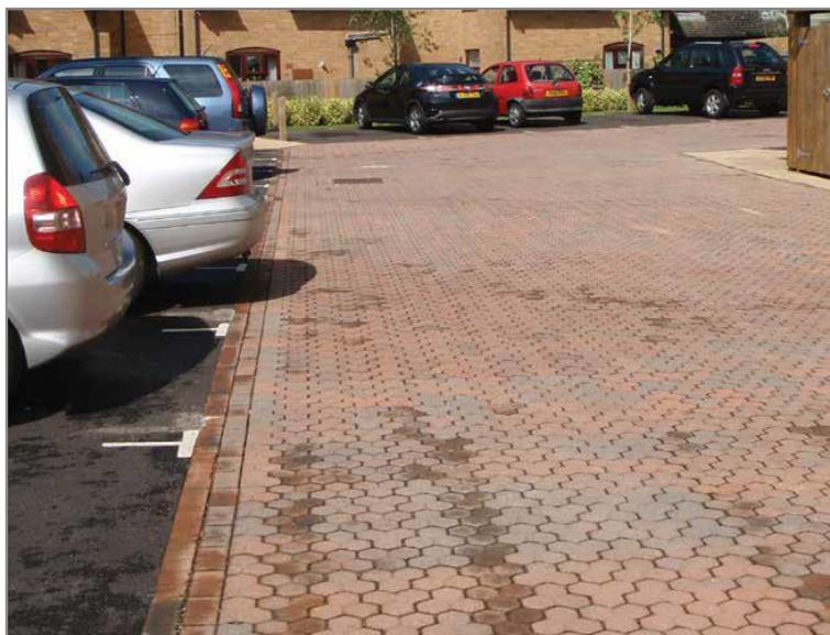
Figura 26.- Pavimento de bloques (Ref. 3)
