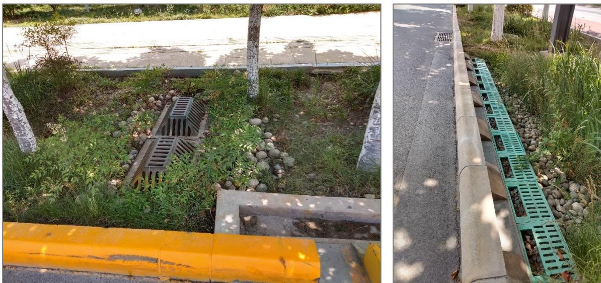
Figura 8.- Izq.: sistema de biorretención. Der.: zanja de infiltración. Ciudad Nueva de Xiam. Fuente: E. Angheben
