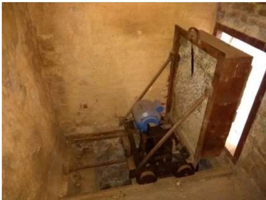
Foto 2.4: Embute de la casa, se puede observar el vano que se cerraba por una compuerta constituida por un delgado marco metálico completado con mampostería que se deslizaba sobre rieles por medio de un mecanismo electromecánico (registro propio, 2019).
