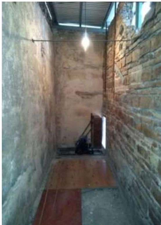
Foto 2.3: Imprenta de la casa, estrecho local construido en el interior del galpón trasero de la casa. Se puede observar la falsa pared de medianera a la derecha y en su extremo el vano para su acceso y salida (registro propio, 2019).
