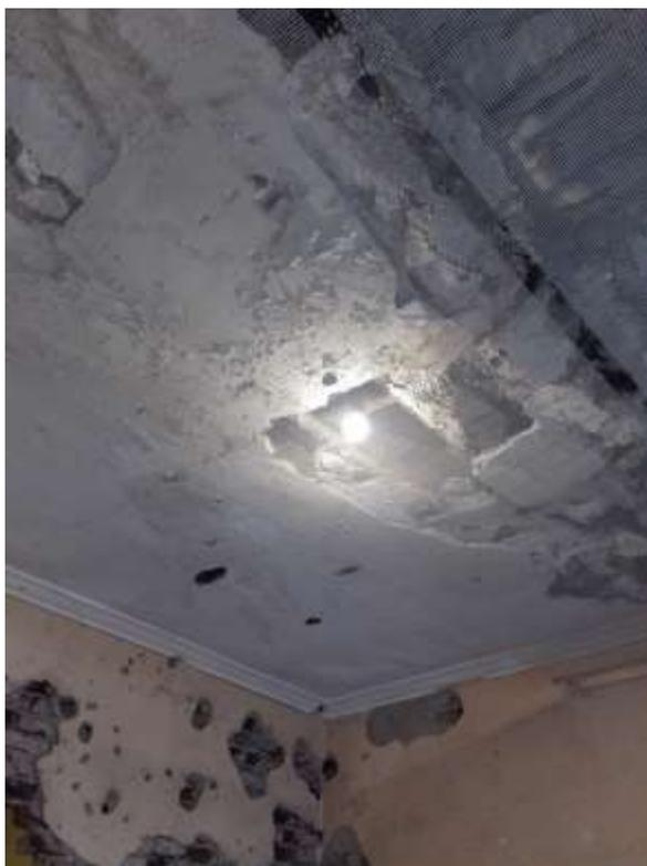
Foto 2.8: Interior de una de las habitaciones en la que se puede observar los múltiples impactos de balas en paredes y techo (registro propio, 2019).
