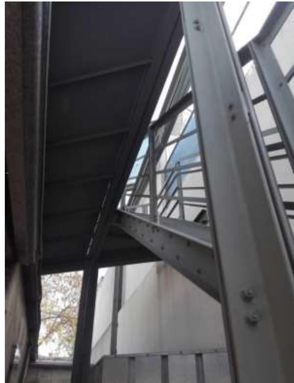
Foto 2.12: columnas de refuerzo y escalera para subir por encima de la casa (registro propio, 2019).
