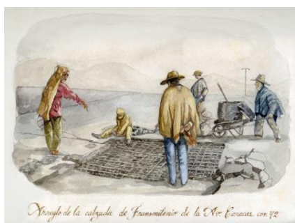
Figura 5. Castro, Carlos. Arreglo de la calzada de Transmilenio de la Av. Caracas con 72. Acuarela en papel de finales del siglo XIX, 2011-2023
