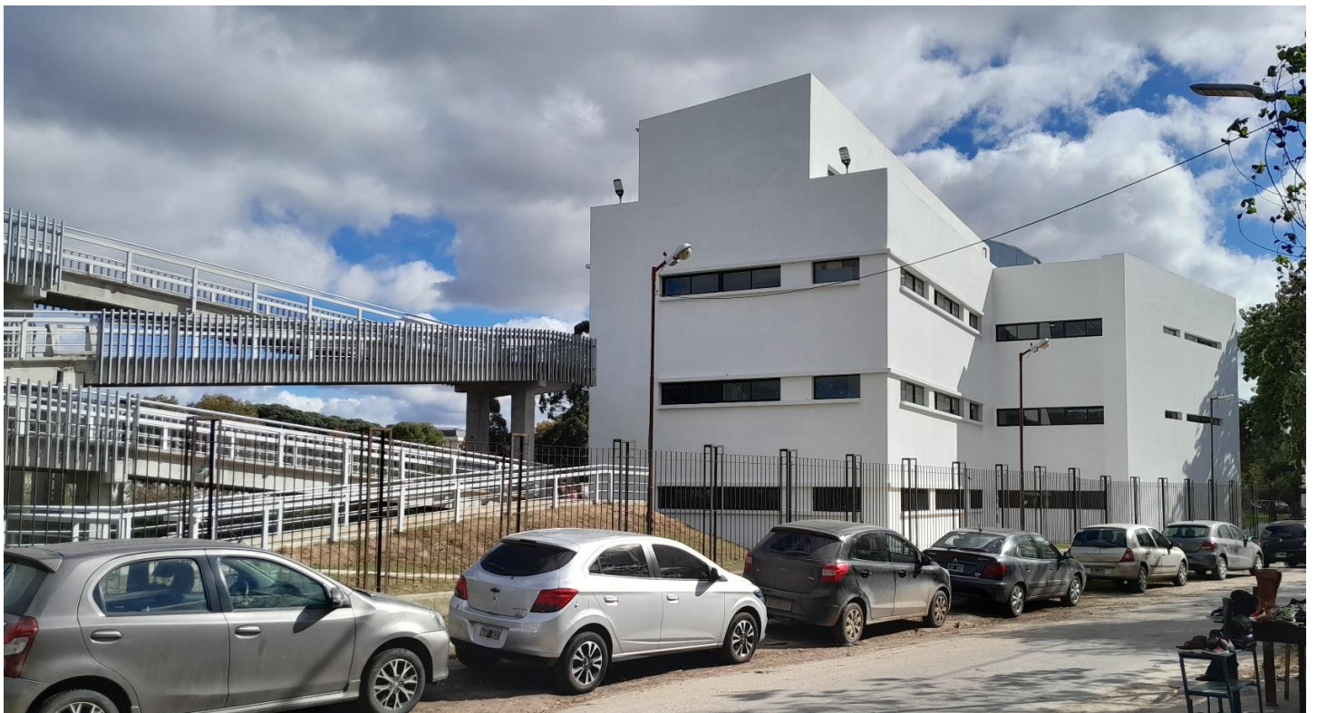
CARA HACIA CALLE URBANA E INICIO PUENTE DE LA CIENCIA
