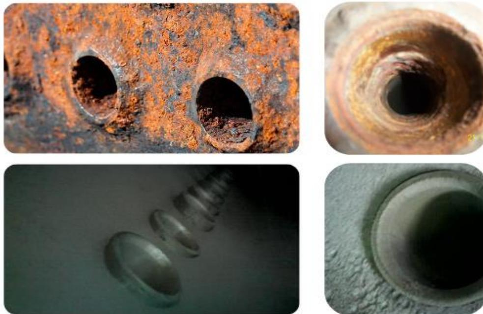
*Imagen 2. Tubos de 2" del interior de una caldera con depósitos calcáreos. Antes y después de una limpieza química operacional (fuente propia).*
