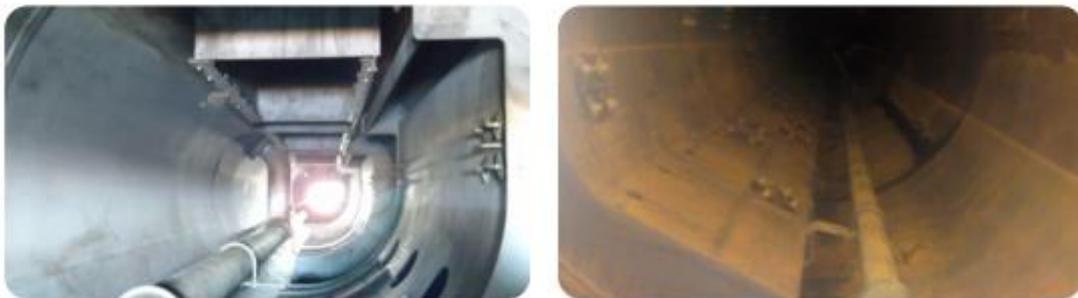
*Imagen 1. Interior de un domo de una caldera de alta recuperación de vapor antes y después de una limpieza química preoperacional (fuente propia)*
