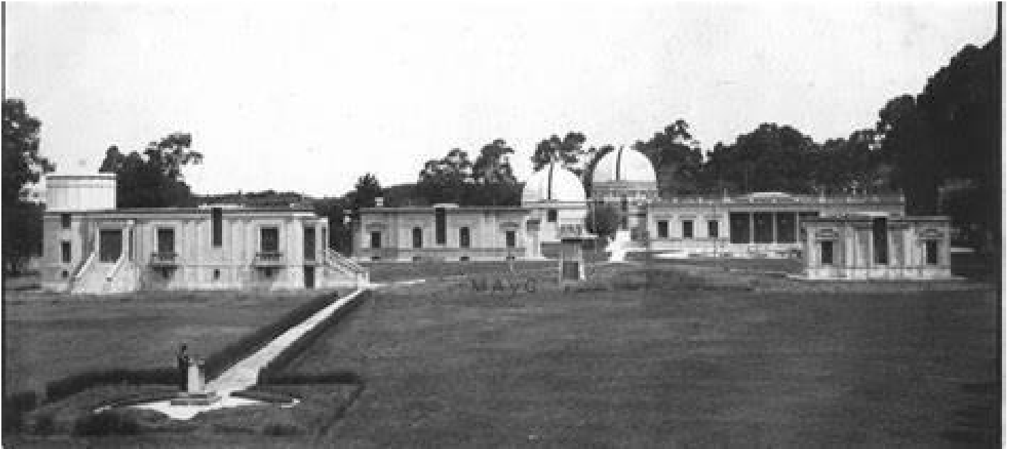
CONJUNTO EDIFICIO FACULTAD DE CIENCIAS ASTRONÓMICAS - VISTA DESDE EL INTERIOR DEL CAMPUS
