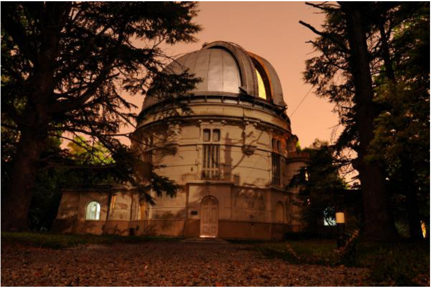
PABELLÓN GRAN ECUATORIAL - FACHADA
