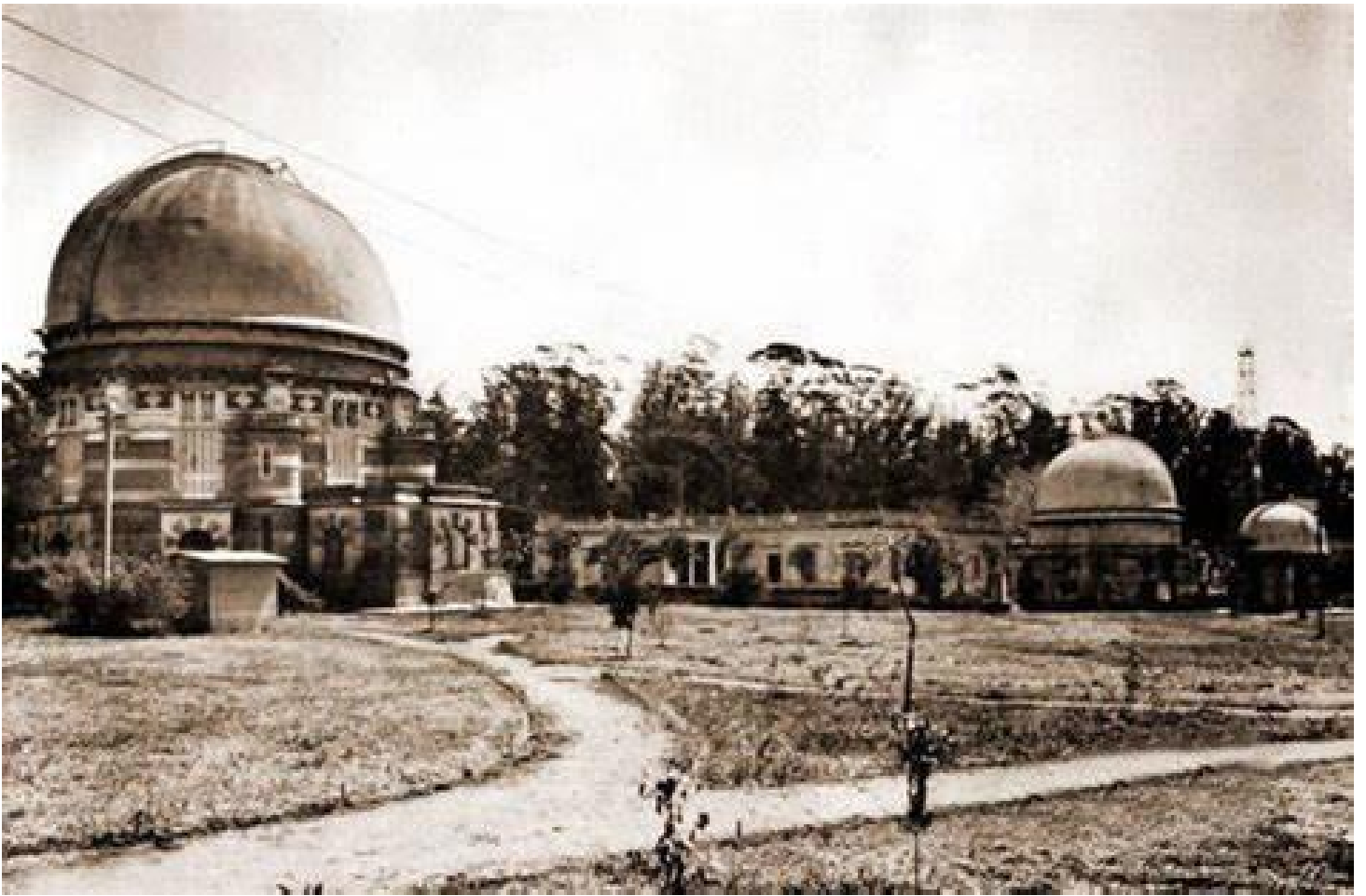
CONJUNTO EDILICIO - VISTA DESDE ESQUINA AV. IRAOLA Y AV. CENTENARIO
