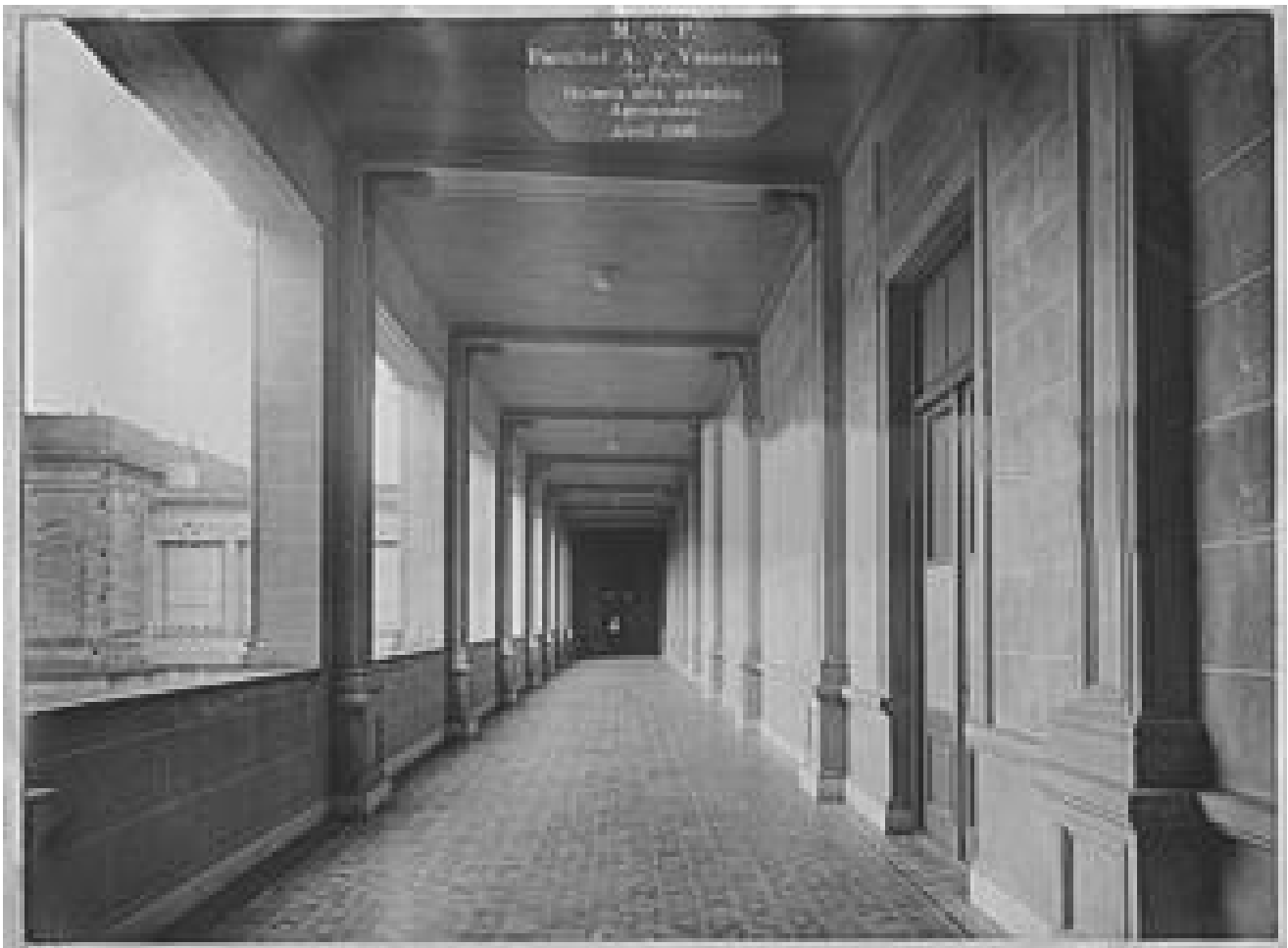
FACULTAD DE CIENCIAS AGRARIAS Y FORESTALES - EDIFICIO CENTRAL (EX FACULTAD DE AGRONOMÍA Y VETERINARIA) / GALERÍAS Y PATIO INTERIOR
