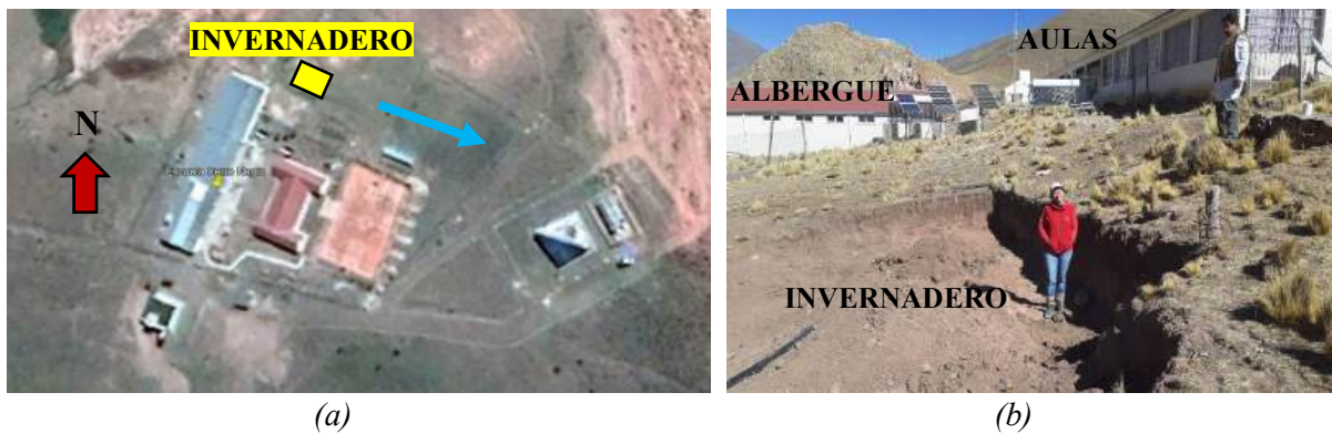
Figura 1: (a) Ubicación del invernadero, (b) excavación y nivelación de terreno.
