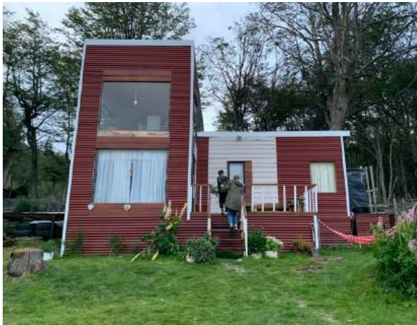
Figura 3 Fachada principal. Vivienda 2.
