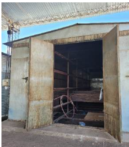
Figura 2: Vista del frente de carga y descarga de la estufa, se observan la estructura de rack para los cuatro niveles de peines.
