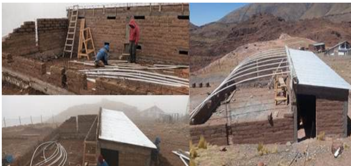
Figura 3: Proceso de construcción del invernadero en la Esc. Albergue N°4587.
