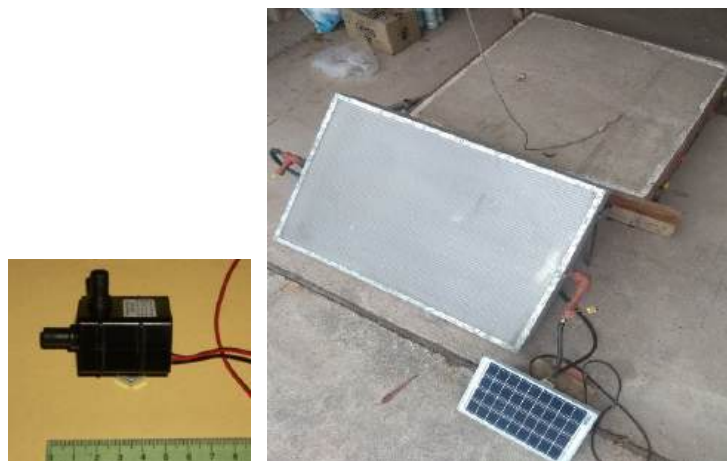
Figura 9. Foto de la mini bomba utilizada para la recirculación, y del piso radiante conectado al colector solar.
