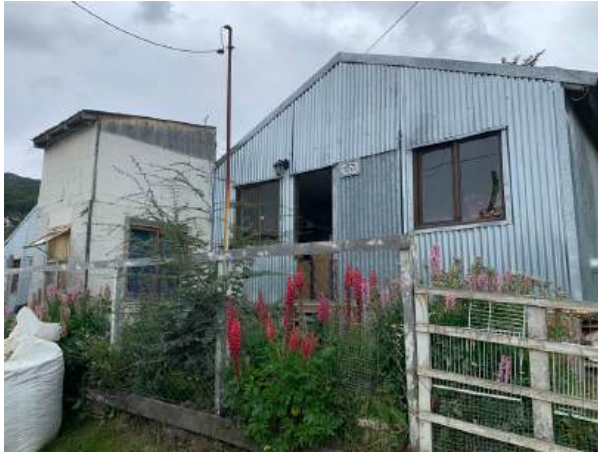
Figura 1 Fachada principal. Vivienda 1.
