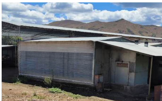
Figura 1: Vista oeste de la estufa de tabaco, con su unidad de calor, antes de ser intervenida.
