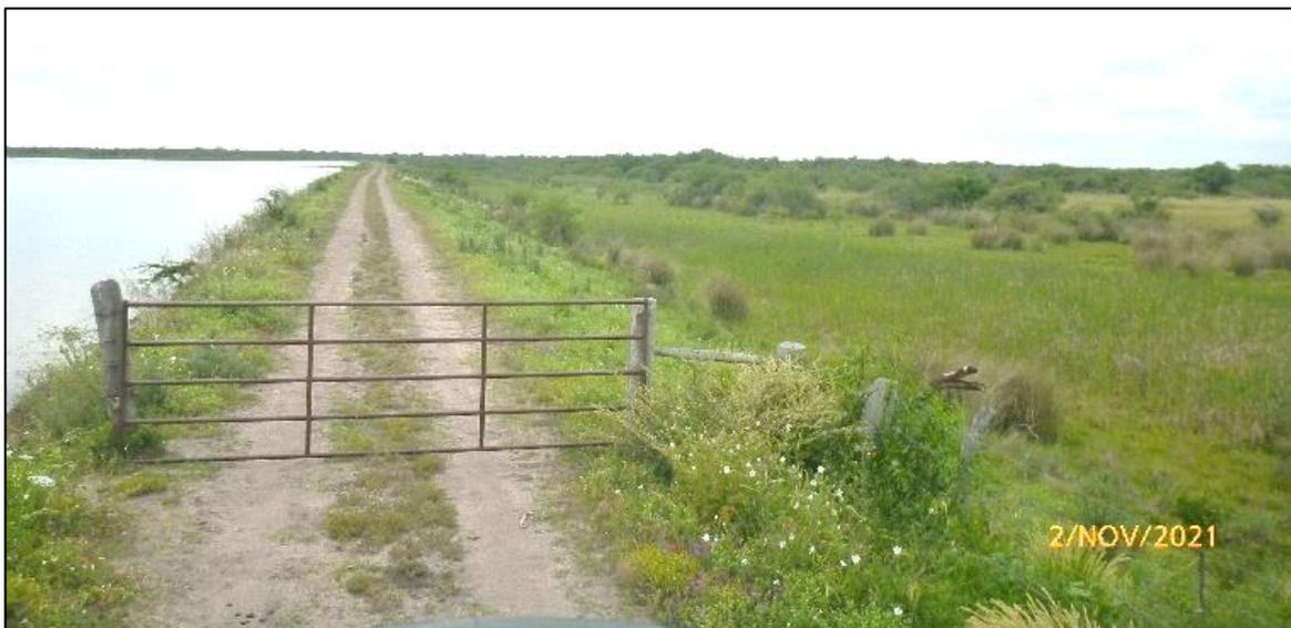
**Figura 55.** Terraplén de una presa arrocera en las cercanías de Cazadores Correntinos, Curuzú Cuatiá, Corrientes. A la izquierda se observa el lago, en el centro la represa vegetada y a la derecha el fondo natural del valle fluvial.
