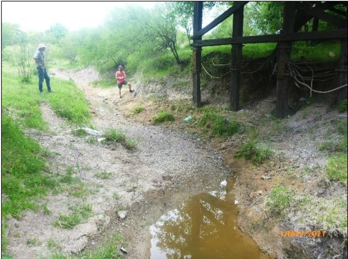
**Figura 97.** La estabilidad de este puente cruzando el arroyo San Victor está comprometida por la erosión afectándolo.
