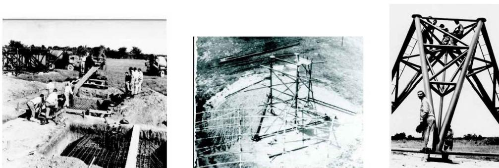
Figura 14 *Izquierda:* Construcción de las bases de cemento armado para el pedestal de los movimientos. *Centro:* Construcción del pedestal sobre las bases de cemento. *Derecha:* Pedestal para el sistema de movimientos terminado.
