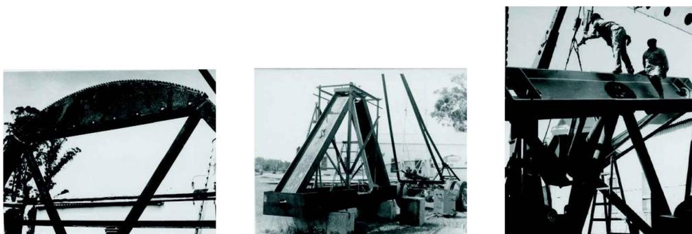
Figura 10 *Izquierda:* Corona para el movimiento en ascensión recta. *Centro:* Eje para el movimiento en declinación. *Derecha:* El sistema de movimientos armado.
