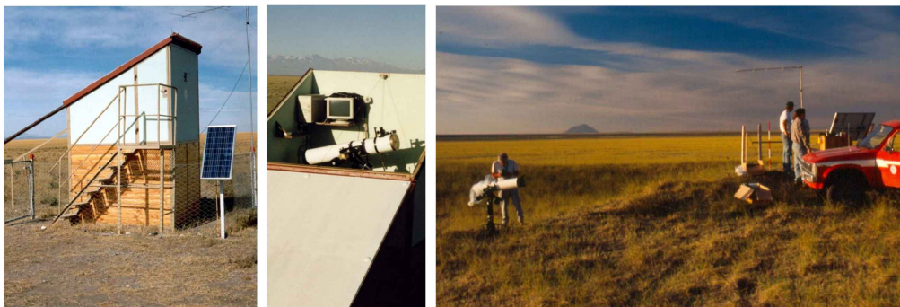
Figura 27 Sistema instalado en Pampa Amarilla (El Nihuil) para la medición de atenuación horizontal (1996-97). Izquierda: Caseta con sistema detector. Centro: Instrumental dentro de la caseta. Derecha: Preparando mediciones de comparación de la lámpara estabilizada a 7.14 km del detector. En el horizonte se observa el Cerro Diamante.
