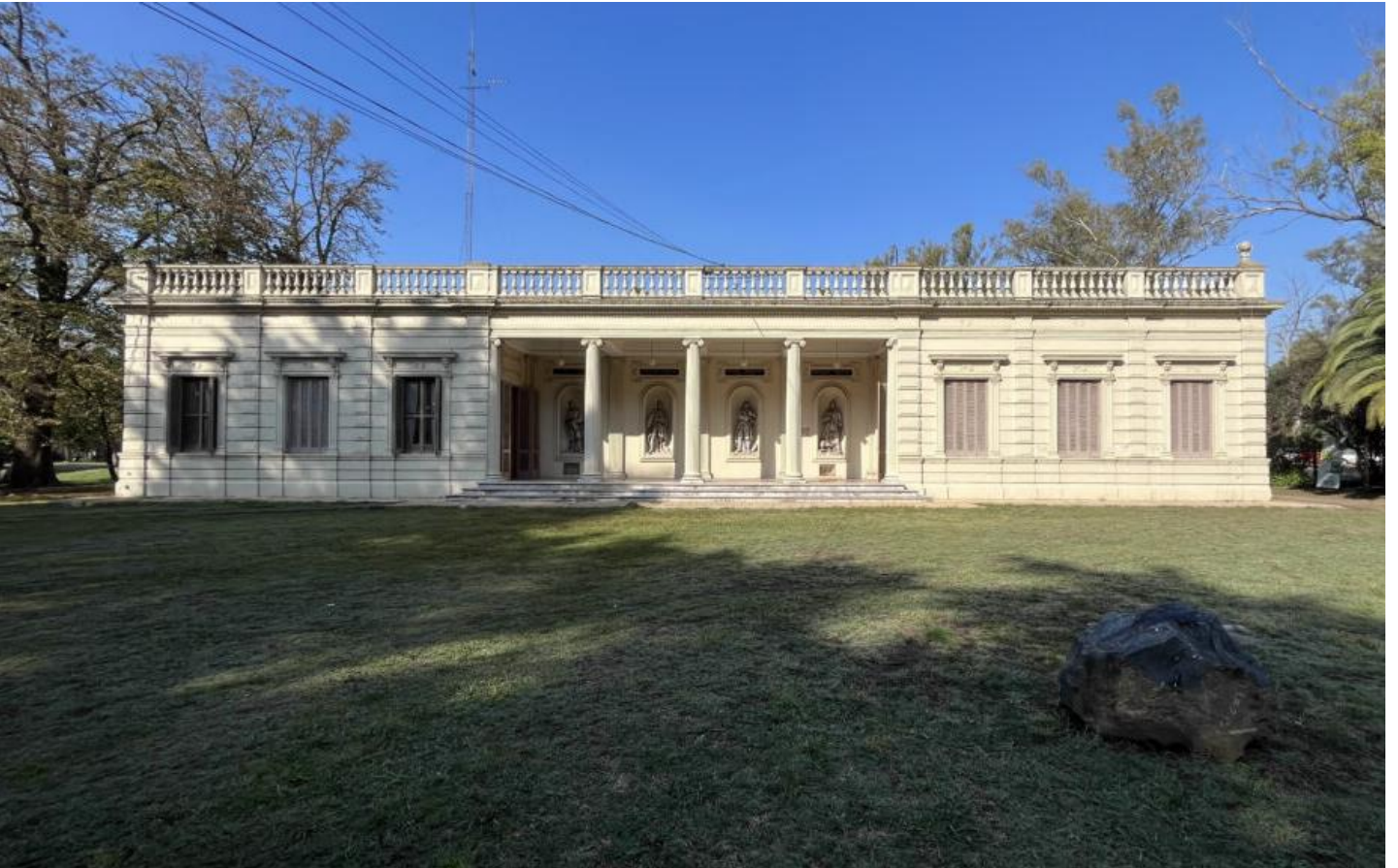
VISTAS ACTUALES NORTE
