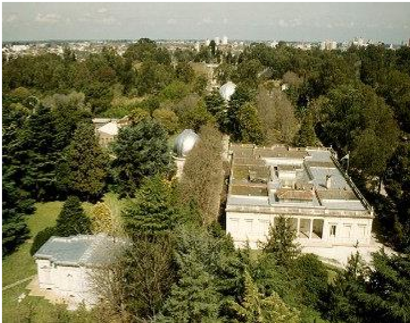
VISTA ACTUAL PANORÁMICA DESDE EL NORTE
