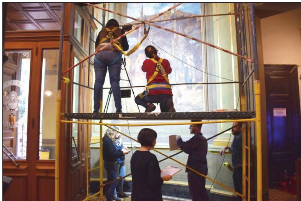
9. Estudios previos realizados sobre una pintura mural testigo de la rotonda principal, mediante la técnica de intervención RTI.
