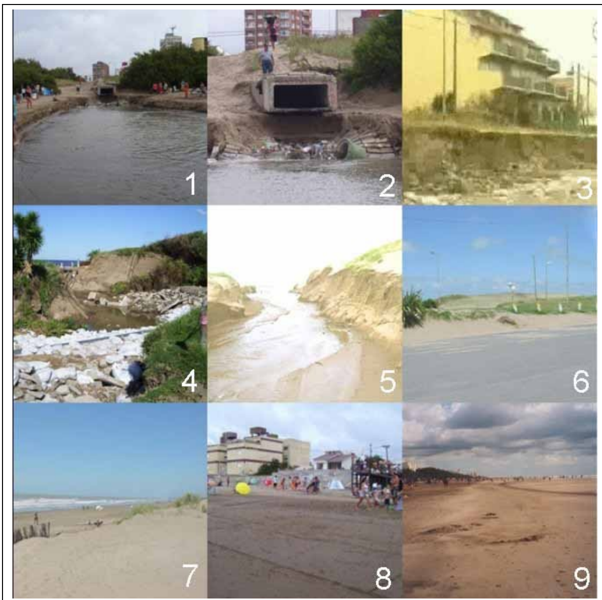
1. Canaleta formada por la desembocadura de un desagüe pluvial; 2. Ídem; 3. Perfil de arena de aproximadamente 1 m de espesor, socavado por el mar luego de una tormenta; 4. Canaleta formada por calle perpendicular a la playa, y soluciones “blandas” a la erosión; 5. Canaleta formada por la desembocadura de una calle hacia la playa; 6. Avenida costanera; 7. Zona de dunas sin forestar; 8. Zona de dunas decapitadas; 9. Zona de dunas forestadas.
