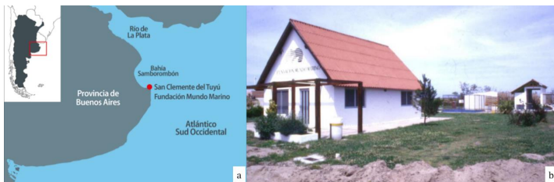
Foto 1. a) Ubicación y b) primer edificio del Centro de Rehabilitación de Fauna Marina de la Fundación Mundo Marino.
