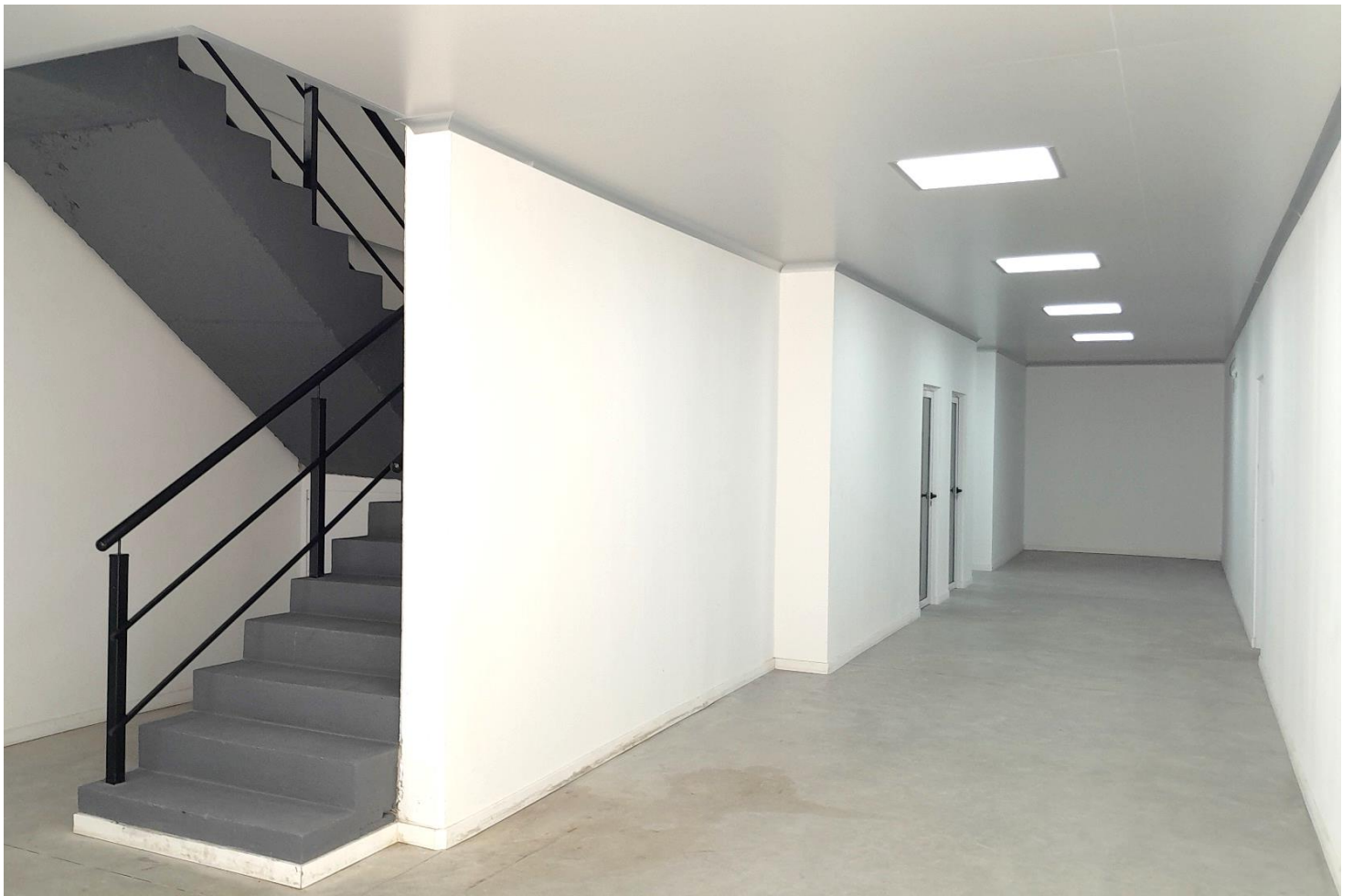
HALL DE ACCESO CIB – SECTOR LABORATORIOS
