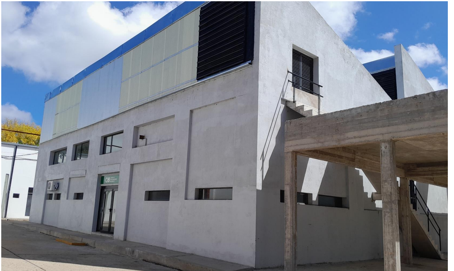
ACCESO AL CIB – SECTOR LABORATORIOS
