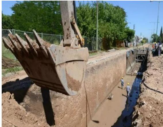
**Fig.179 y 180: Las obras de ensanche y profundización del cauce del Arroyo El Gato (2019)**
