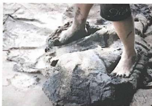
Aplastado con pies en línea horizontal para asegurar la penetración del polvo de ladrillos.
