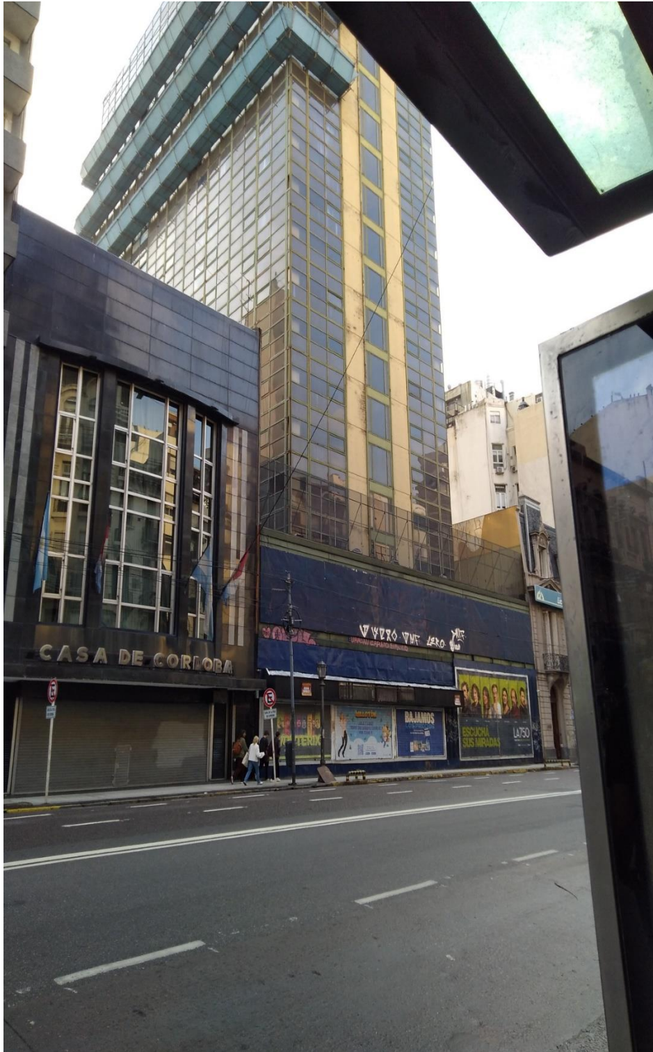
Fotografías de octubre 2024 sobre la fachada del hotel Bauen, Av Callao 269, CABA.
